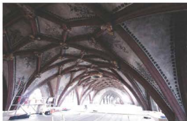
Blick in die Baustelle unter dem Chorgewölbe (Vorzustand 2014)
