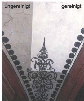
Reinigungsmuster in einer Gewölbekappe 2014
