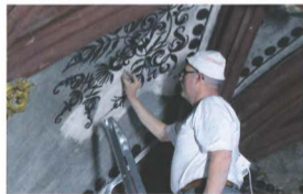
Trockenreinigung der Gewölbekappen mit Akapad-Schwämmen
