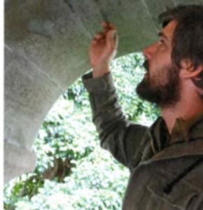
Der Stein ist weich und platzt ab. Mit Kieselsäure-ethyltester wird anschliessend verfestigt.
