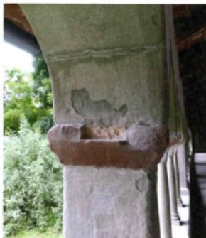
Loose Schichten der Fensterbögen werden entfernt und grössere Fehlstellen aufgefüllt.
