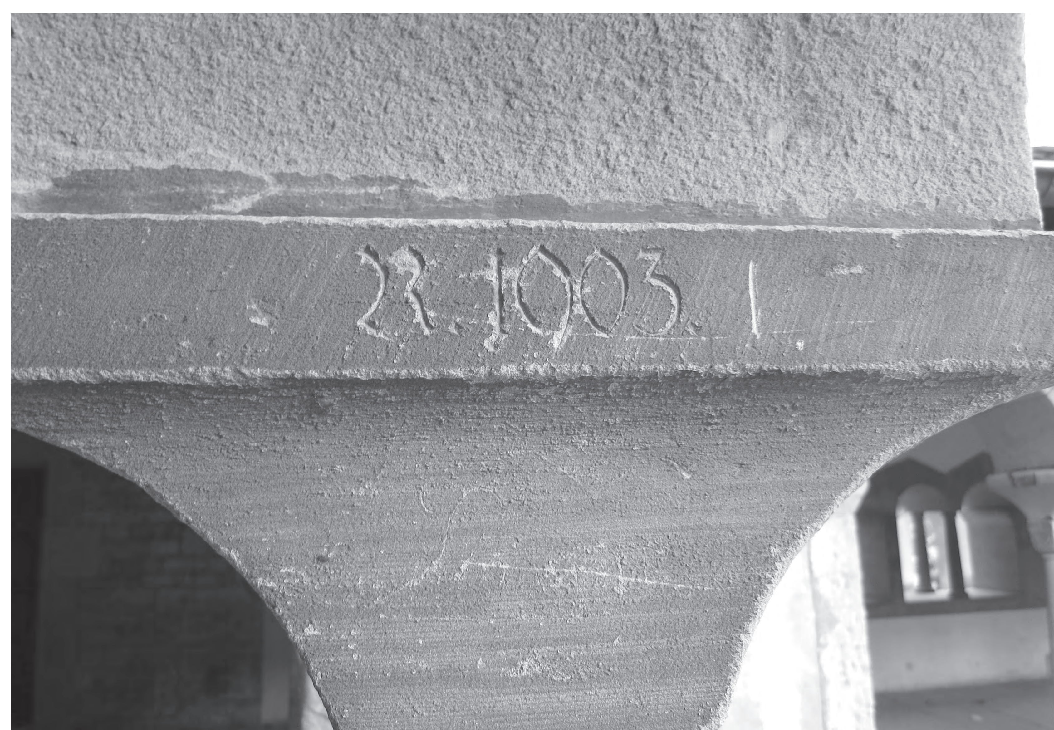
Scharriertes Werkstück mit Gravur, 1903
