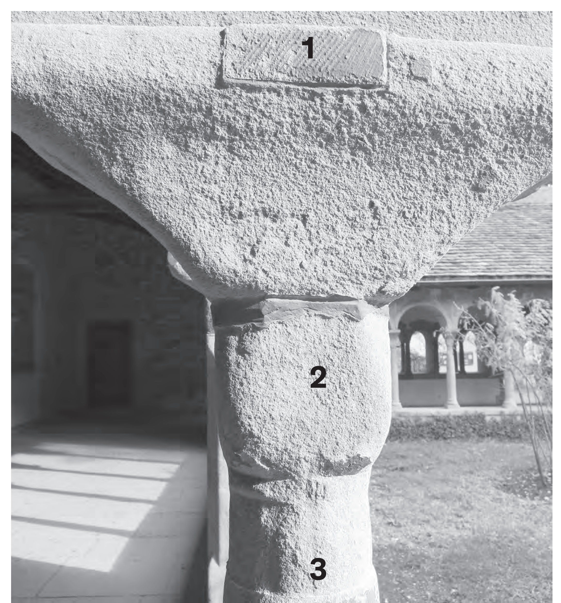
1 Vierung im Kämpferansatz, 1903 2 Kapitell wiederverwendet 3 Holzsäulenersatz, 1903
