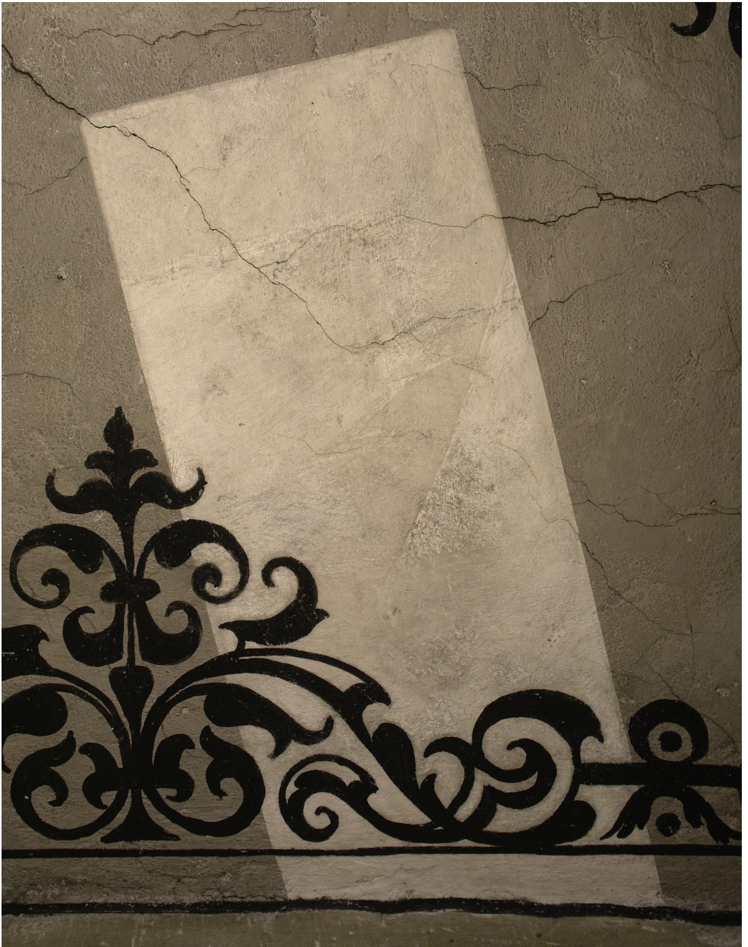
03: Reinigungsprobe Februar 2015. Trockenreinigung mit Latexschwamm. Foto: Berner Münster-Stiftung, Bern.
