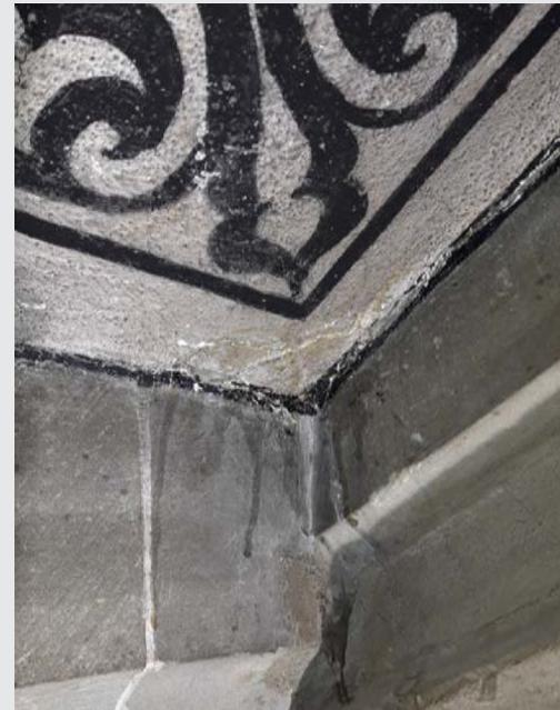
Klebstelle im Eckbereich einer Kappe zur Sicherung loser Mörtelstücke. Laufspuren auf dem Stein und bräunliche Verfärbungen sichtbar. Diese Notmassnahmen erfolgten 1993.
