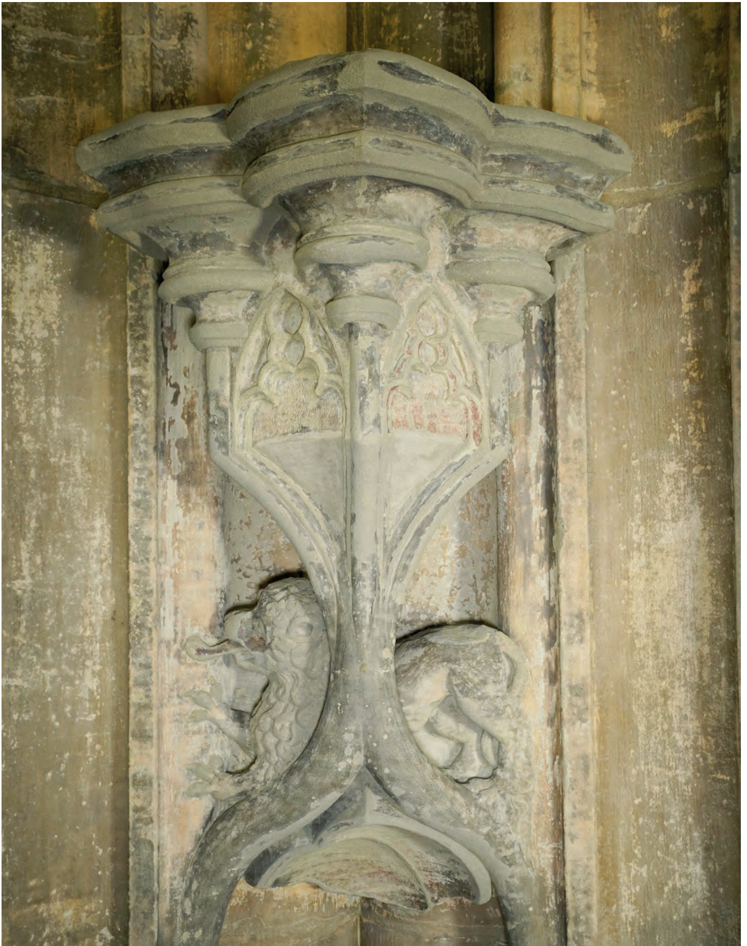
03: Detail Westportal Nord (Figurenkonsole Ost) während der Restaurierung. Gut erkennbar sind die vielen kleinen Mörtelergänzungen, welche später noch retuschiert wurden. Foto: Berner Münster Stiftung, Bern.
