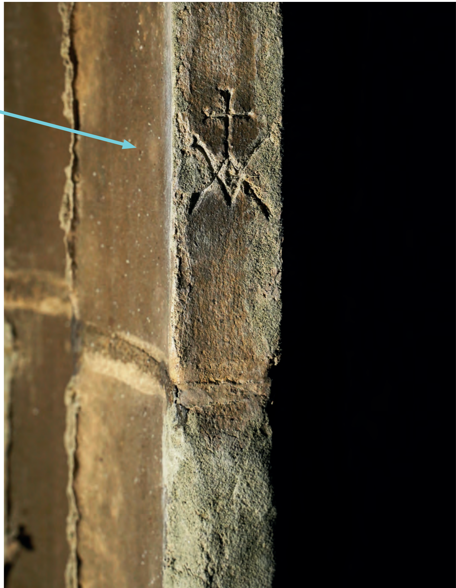
05: Detail Westportal Nord: Gewölberippe von 1575. Links im Vorzustand mit stark aufblätternden Steinoberflächen - das Steinmetzzeichen ist kaum mehr zu erkennen. Rechts: nach der Konservierung durch die Münsterbauhütte. Die aufstehenden Steinschollen wurden zurückgelegt, die Oberflächen verfestigt. Das Steinmetzzeichen aus dem 16. Jh. ist wieder gut lesbar.
