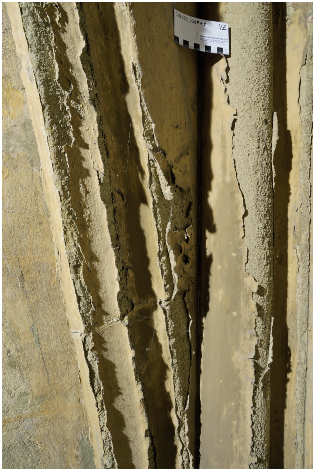
02: Detail Westportal Nord (Gewölbeanfänger): Links angetroffener Zustand 2019 mit stark verwitterter Oberfläche, rechts Zustand nach der Konservierung durch die Münsterbauhütte 2021. Die Aufstehenden Schollen konnten zurückgelegt, die Fehlstellen mit Mörtel geschlossen und die Farbfassung erhalten werden. Foto: Berner Münster Stiftung, Bern.
