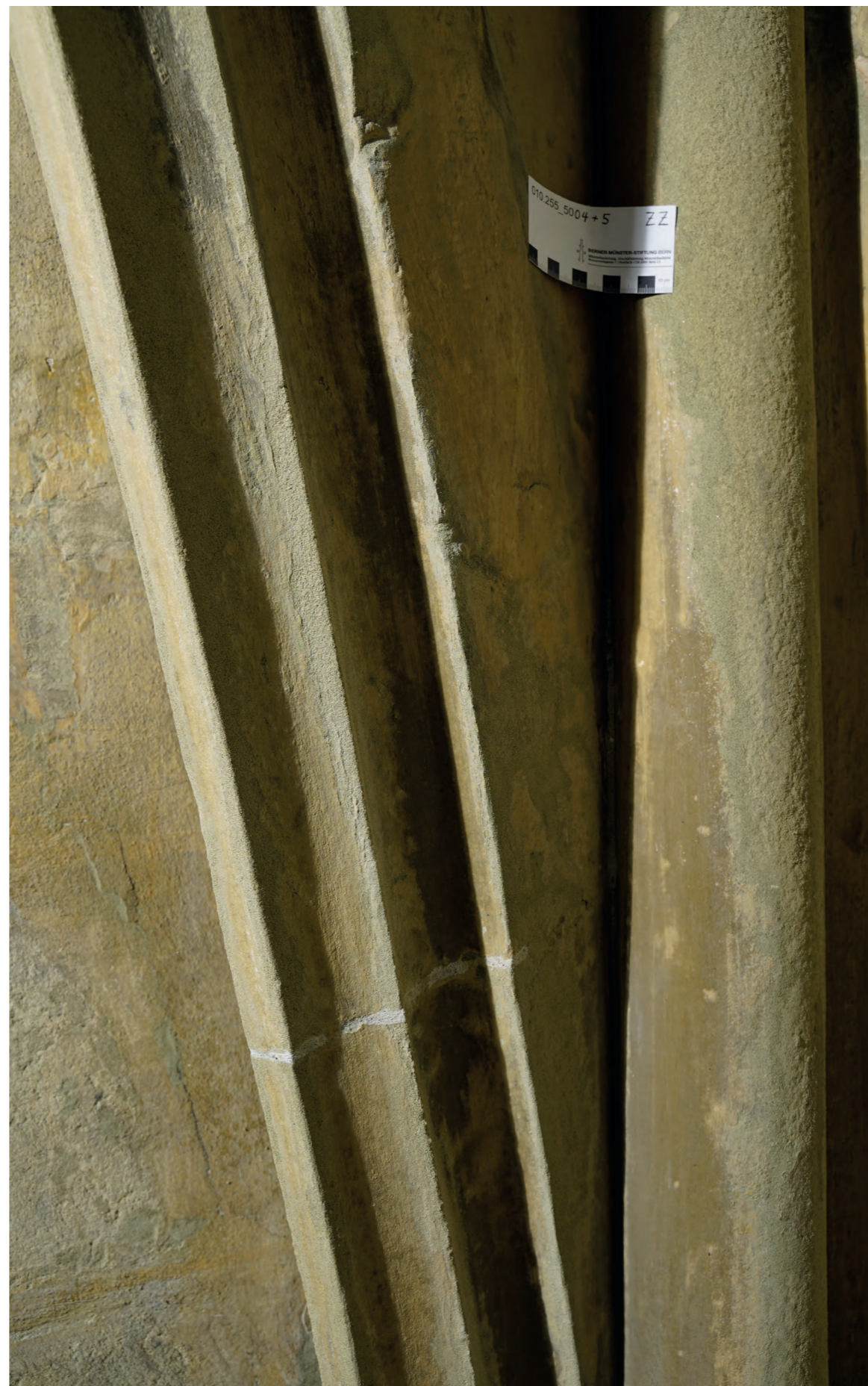
02: Detail Westportal Nord (Gewölbeanfänger): Links angetroffener Zustand 2019 mit stark verwitterter Oberfläche, rechts Zustand nach der Konservierung durch die Münsterbauhütte 2021. Die Aufstehenden Schollen konnten zurückgelegt, die Fehlstellen mit Mörtel geschlossen und die Farbfassung erhalten werden. Foto: Berner Münster Stiftung, Bern.
