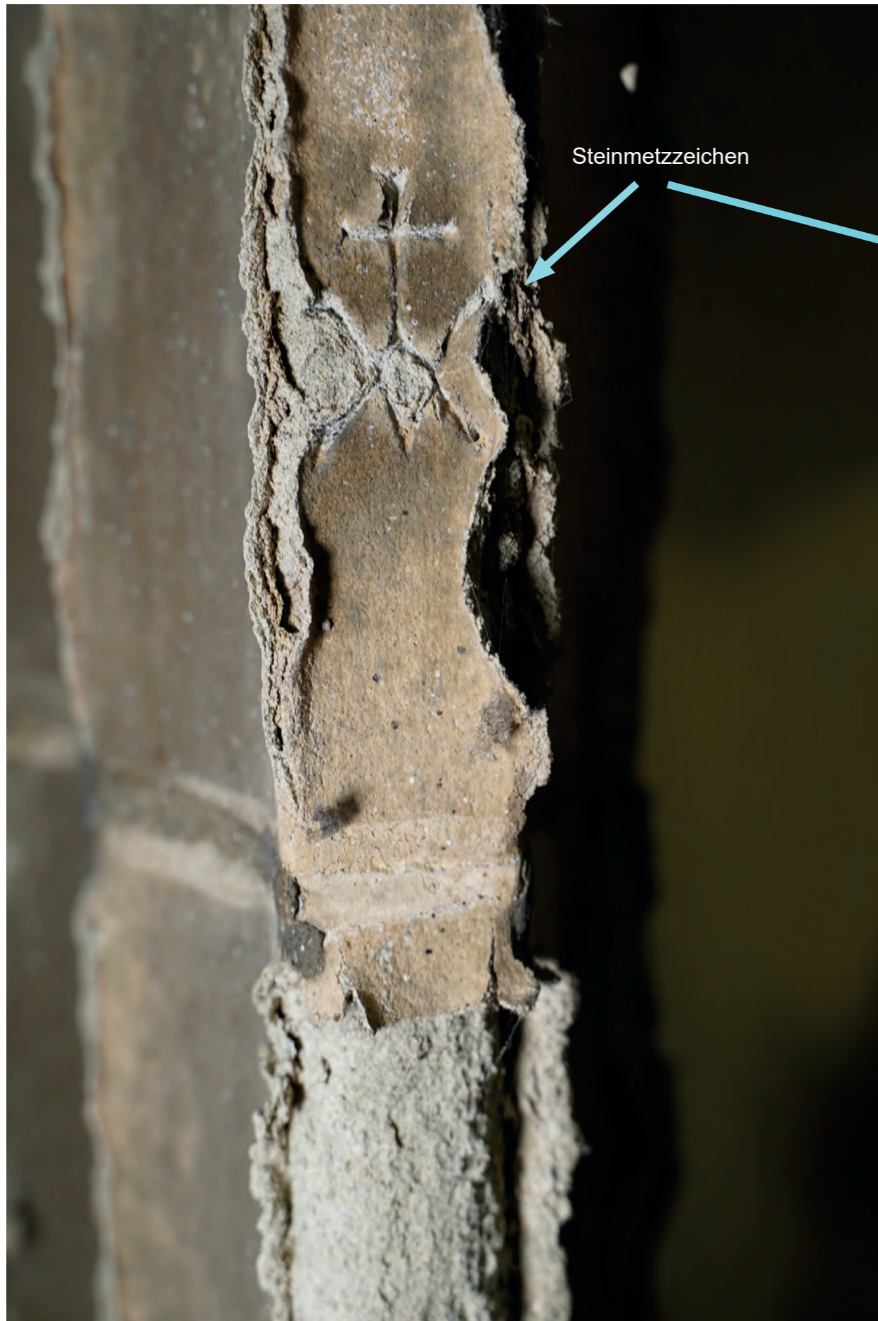
05: Detail Westportal Nord: Gewölberippe von 1575. Links im Vorzustand mit stark aufblätternden Steinoberflächen - das Steinmetzzeichen ist kaum mehr zu erkennen. Rechts: nach der Konservierung durch die Münsterbauhütte. Die aufstehenden Steinschollen wurden zurückgelegt, die Oberflächen verfestigt. Das Steinmetzzeichen aus dem 16. Jh. ist wieder gut lesbar.
