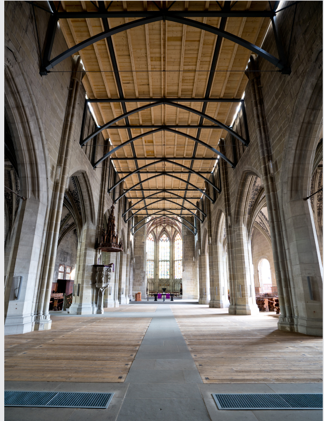
Gerüstplattform im Mittelschiff kurz nach der Fertigstellung, August 2021.
