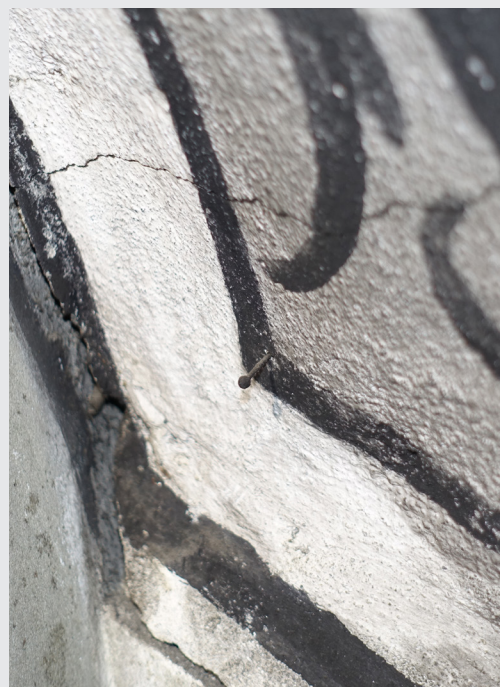
Die Lochpausen wurden zum Übertragen am Putz befestigt. An einer versteckten Stelle konnte ein Nagel aus der Bauzeit entdeckt werden.
