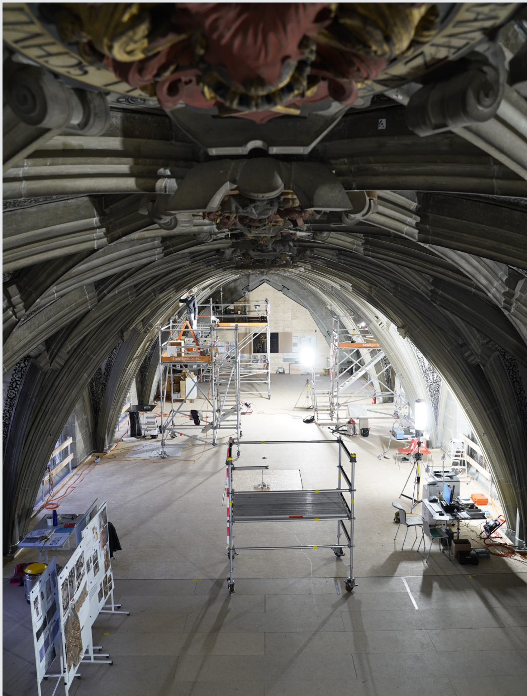
Blick auf die Baustelle.
