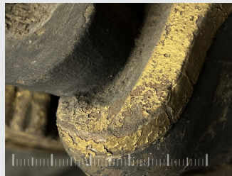
Zustand nach der Reinigung.
