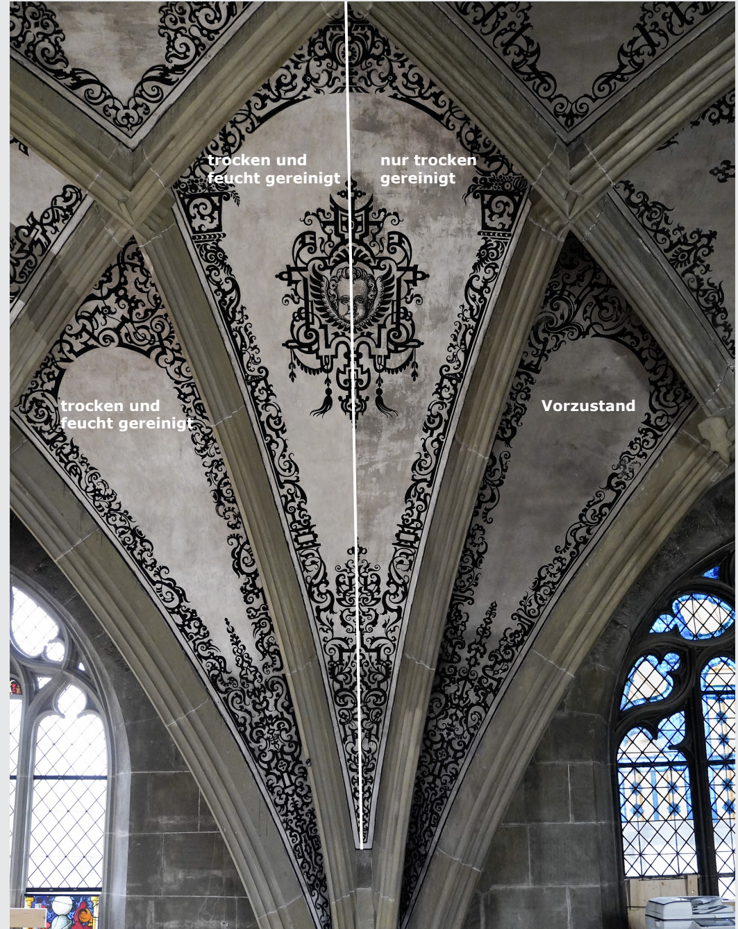
Die Referenzkappen (050-060.230) zeigen die unterschiedlichen Reinigungsstufen. Kappe rechts: Vorzustand, die Fläche ist noch nicht gereinigt. Mittlere Kappe (rechte Hälfte): Zustand nach der Trockenreinigung. Mittlere Kappe (linke Hälfte) und Kappe links: Zustand nach dem zweiten Reinigungsschritt, die Putzoberflächen wurden hier bereits trocken und feucht gereinigt.
