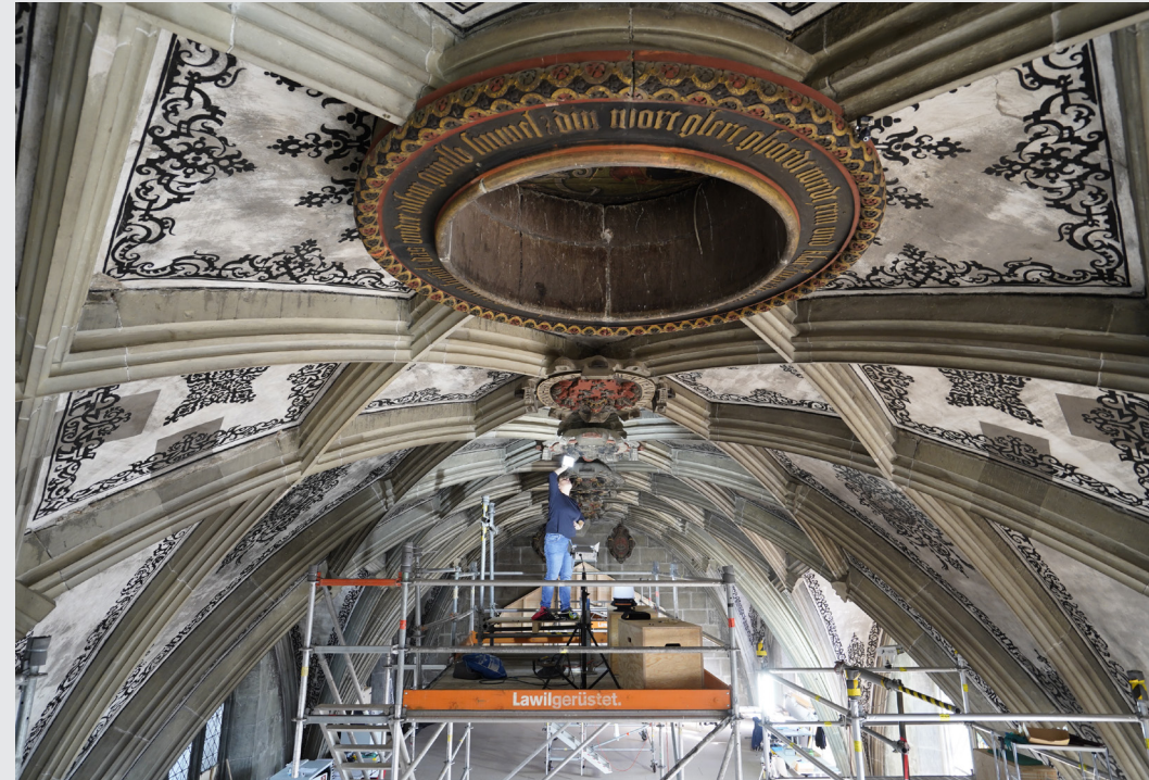
Eindruck während der Arbeiten an den Gewölbeflächen.
