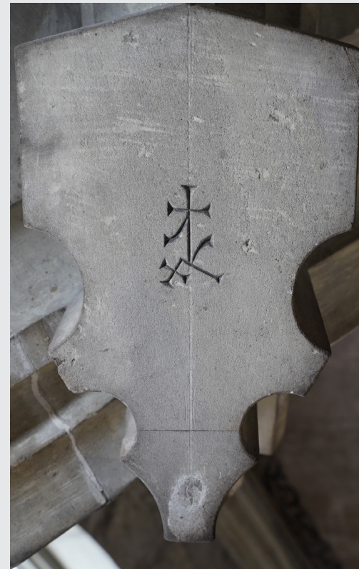
Steinmetzzeichen auf der Stirnfläche einer Gewölberippe.
