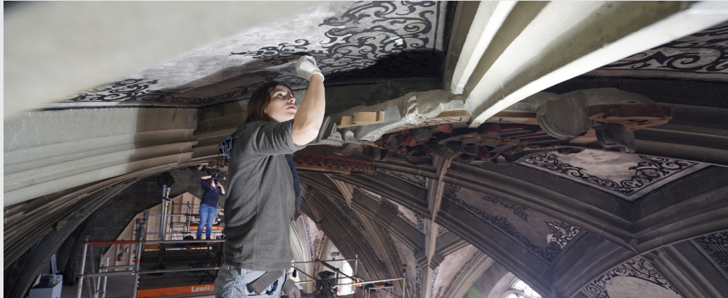
Die Trockenreinigung der Gewölbekappen erfolgt mit Latexschwämmen und erfordert viel Sorgfalt.
