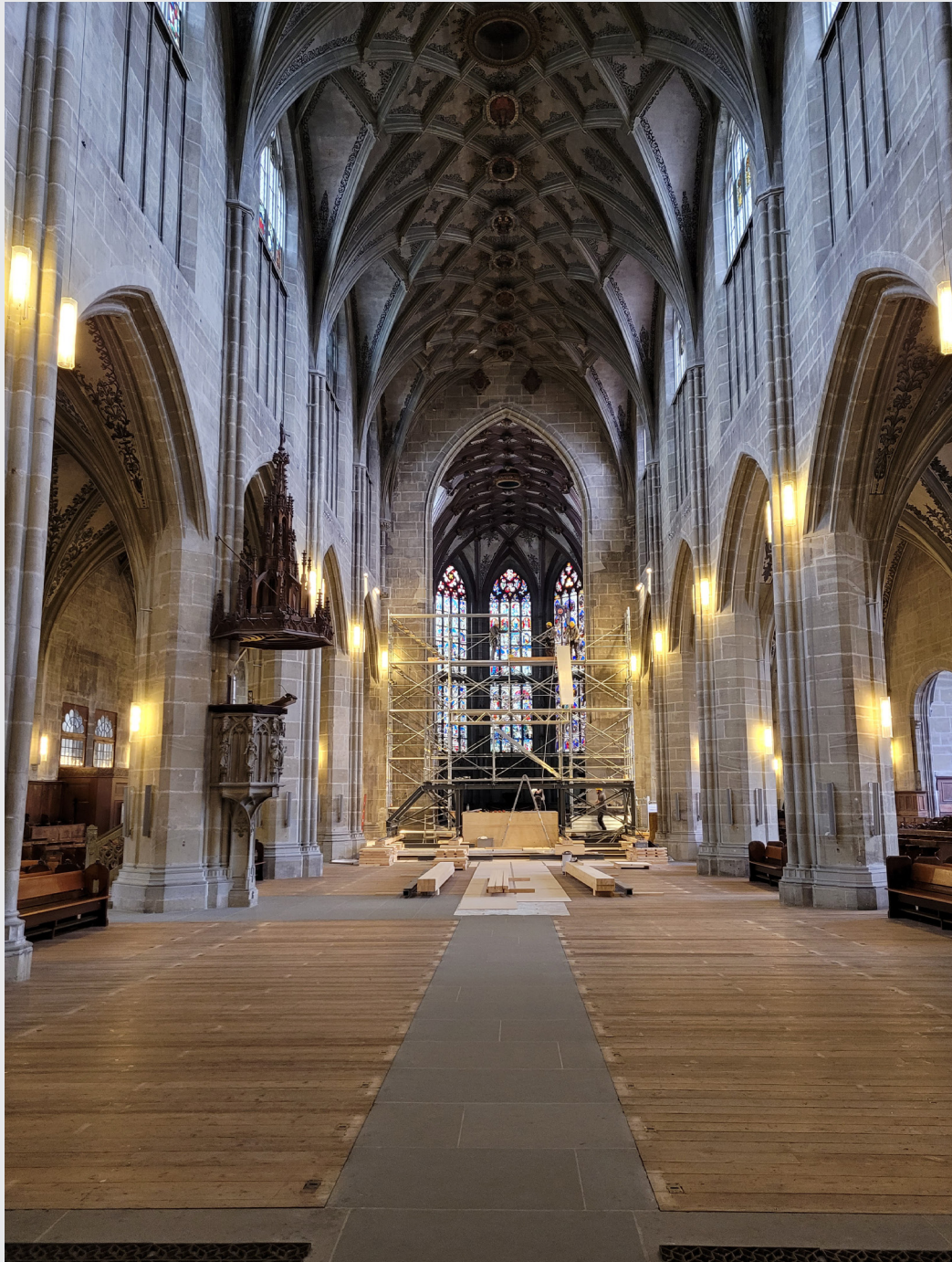
Blick ins Mittelschiff beim Baustart der Gerüstplattform.
