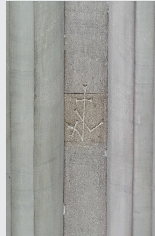
Hier wurde das Steinmetzzeichen in eine kleine Vierung eingraviert. Das Material der Vierung ist an dem gelblichen Farbton gut erkennbar, eingeklebt wurden Vierungen mit einem erhitzten Baumharz.
