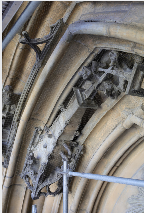
Das gespannte und fixierte Netz integriert sich sehr gut und ist kaum sichtbar.
