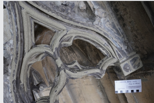
Gleiches Detail mit partiell aufgemörtelten Profilkanten, vor der Retusche.
