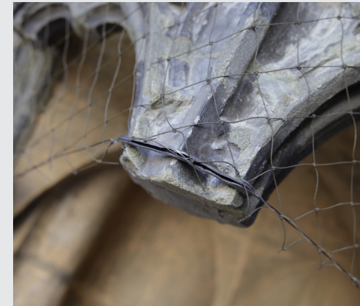
An Stellen, wo die feinen Stahlseile am Stein anliegen, werden zum Schutz des Portals und des Netzes Schoner aus feinem Bleiblech dazwischengesetzt.
