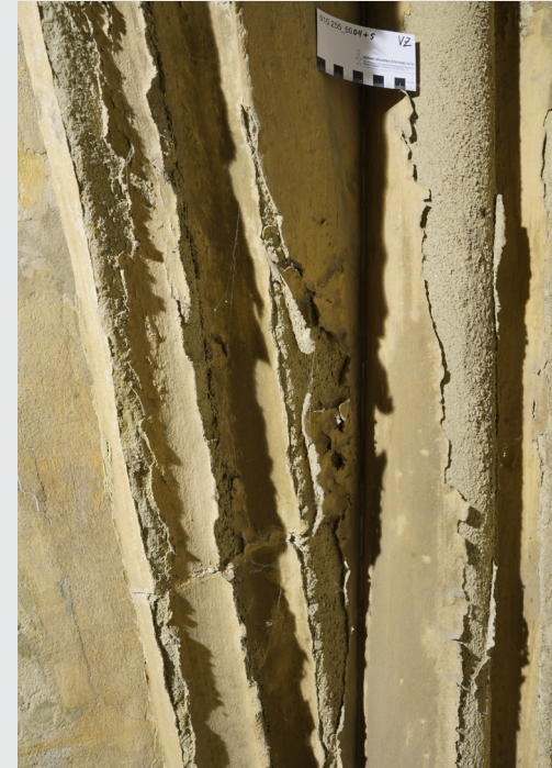
Detail des nordwestlichen Gewölbbeanfängers (1575) vor und nach der Oberflächenkonsolidierung und mit Stützkittungen und Ergänzung der Kanten.
