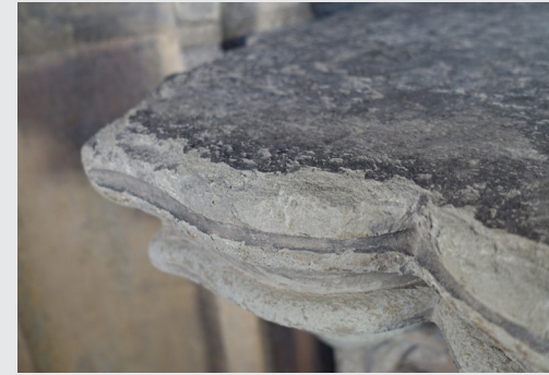
Arbeitsschritte der Kieselsole Kittungen: Vorzustand.
