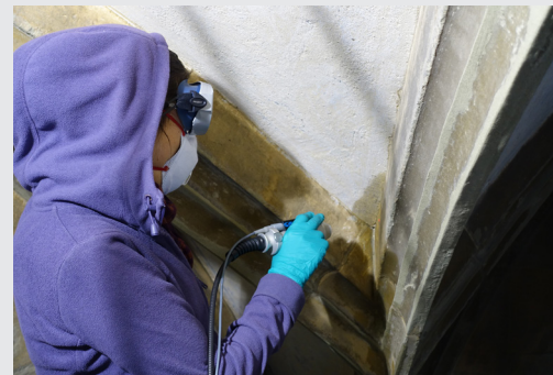
Bei der Laserreinigung sind Konzentration, Genauigkeit und entsprechende Schutzausrüstung gefordert, wie hier bei der Reinigung mit dem Laser im oberen Bereich der Ostwand und an den Rippen.
