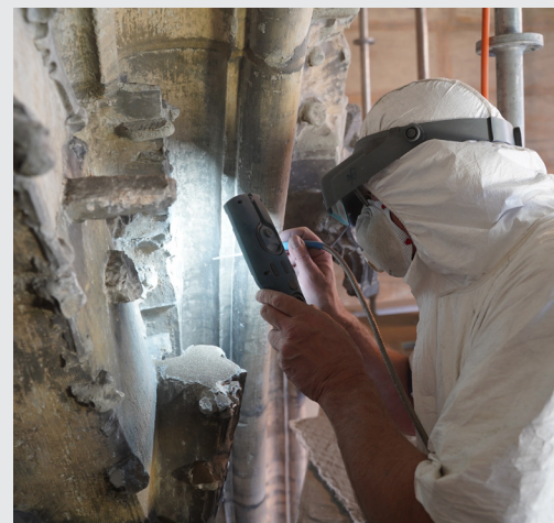
Die Reinigung mit dem Mikrosandstrahlgerät erfordert höchste Konzentration.
