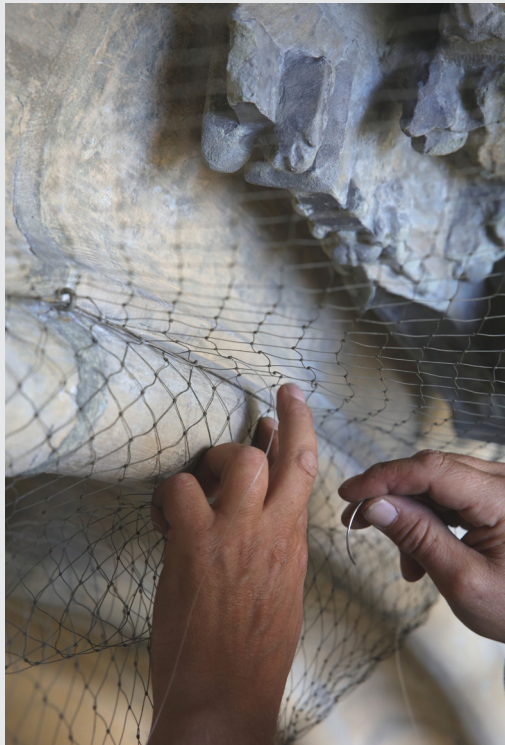
Mit speziellen Nadeln und Nylonfaden wird das Netz an die feinen Stahlseile angenäht.
