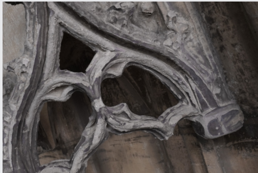
Fragment eines durchbrochenen Baldachins mit Bruchflächen und verwitterten Profilen.
