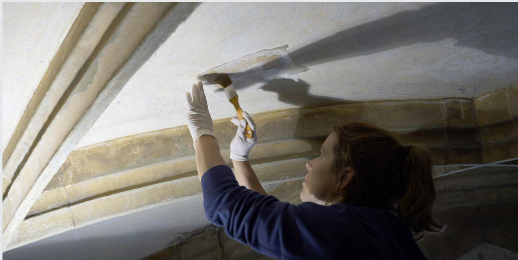
Festigung der Gewölbemalerei.
