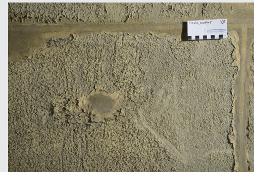
Detailaufnahme der Nordwand vor und nach der Oberflächenkonsolidierung mit Kieselsol. Die Steinoberfläche mit Resten des hellbeigen Anstriches von 1775 war stark abschuppend.
