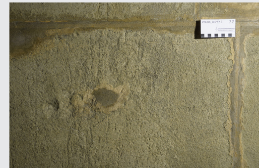
Detailaufnahme der Nordwand vor und nach der Oberflächenkonsolidierung mit Kieselsol. Die Steinoberfläche mit Resten des hellbeigen Anstriches von 1775 war stark abschuppend.
