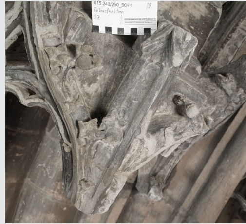
Eine der ersten Musterflächen zur Kittung der Fehlstellen in der Portalplastik mit Kieselsolemörtel im Vorzustand links und Schlusszustand rechts.
