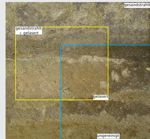
Musterfläche am Bau: Reinigung mit Mikrosandstrahlgerät und Laser im Vergleich.
