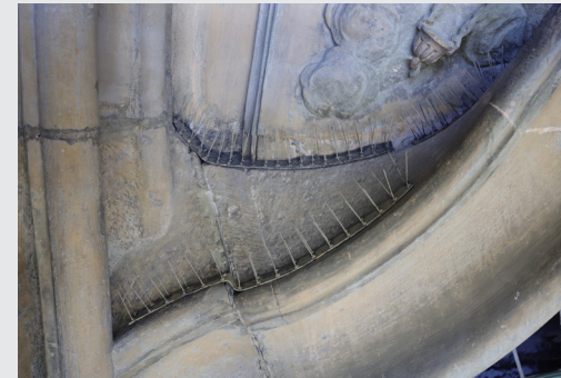
Ansicht der Vogelspitzen frontal und von oben. Das Bleiblech der Vogelspitzen passt sich sehr gut der Portalgeometrie an und ist von unten kaum erkennbar.
