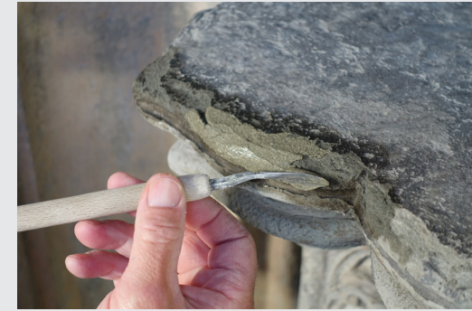
Arbeitsschritte der Kieselsole Kittungen: Mörtelantrag.
