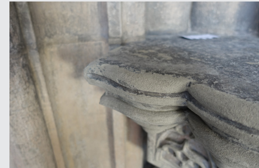
Arbeitsschritte der Kieselsole Kittungen: Schlusszustand, noch ohne Retuschen.
