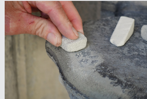
Arbeitsschritte der Kieselsole Kittungen: getrocknet, in Form schleifen.
