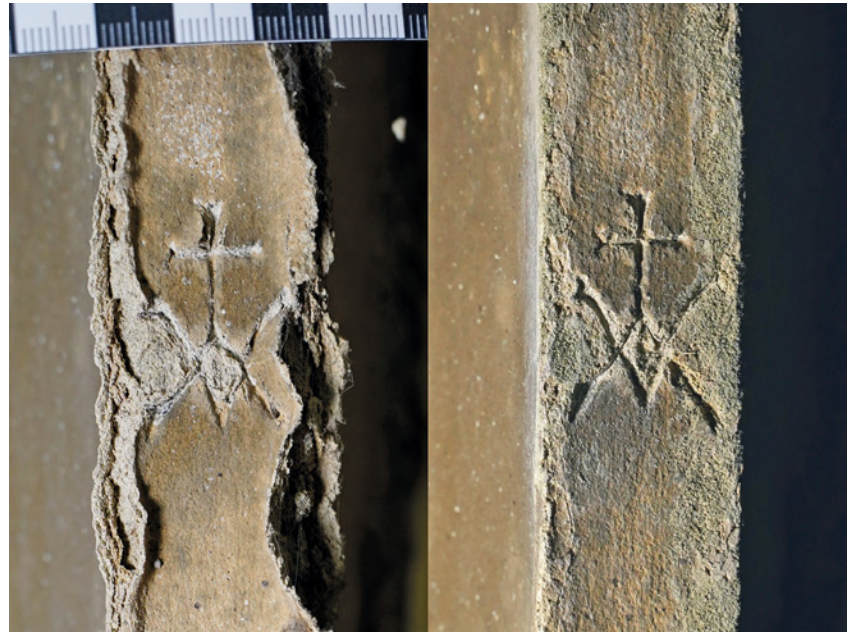
Bild 22 Ein Steinmetzzeichen am Profilstege einer Gewölberippe im Vorzustand links und rechts im Schlusszustand nach der Oberflächenkonsolidierung und dem Ergänzen der Profilkanten (Streiflicht von links)
