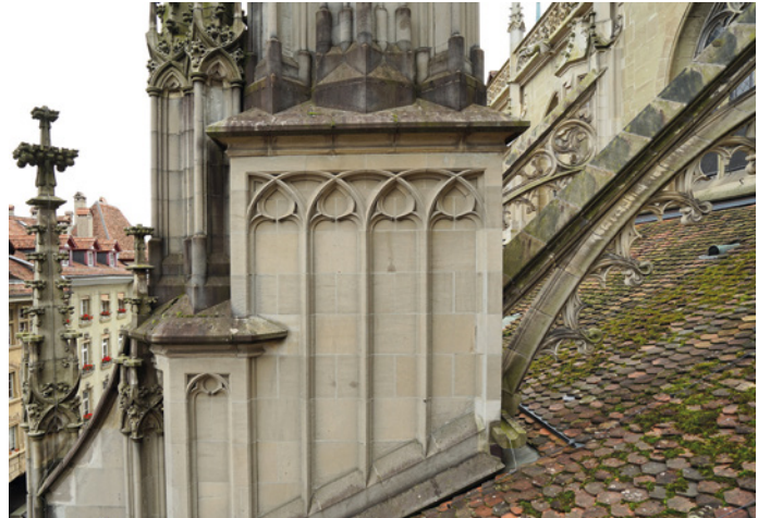
Bild 4 Blick auf den Strebpfeiler aus Zuger Sandstein und Strebebogen aus Obernkirchener Sandstein
