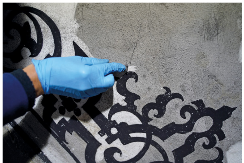
Bild 35 Bei der Reinigung mit Naturlatexschwämmen wird sorgfältig um die Ornamente herum gearbeitet.
