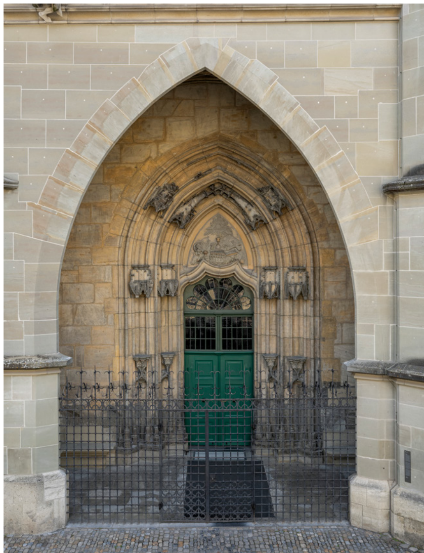
Bild 28 Gesamtaufnahme Westportal Nord im Schlusszustand, aufgenommen 2022
