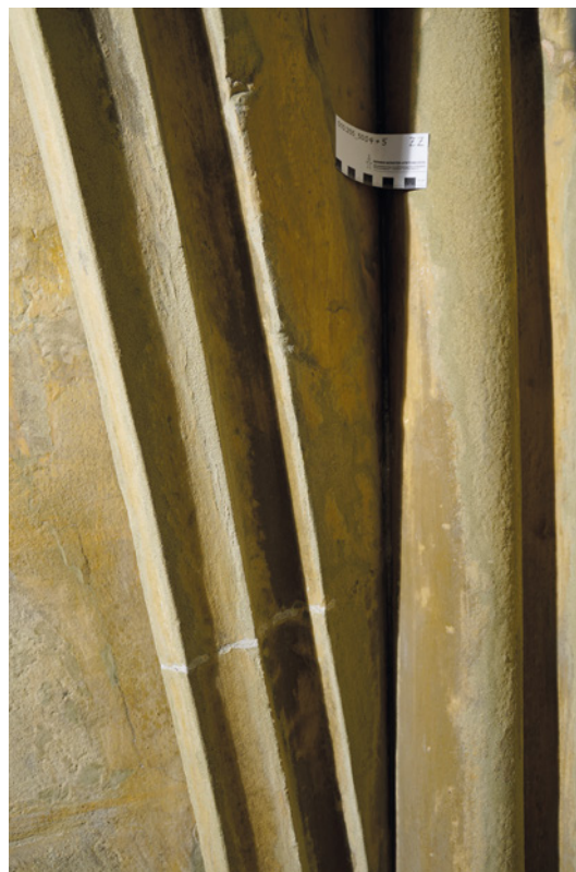
Bild 23 Stark abblätternde Oberflächen (Malschichten mit Sandstein) am nordwestlichen Gewölbeanfänger, Vorzustand (Streiflicht von links)
