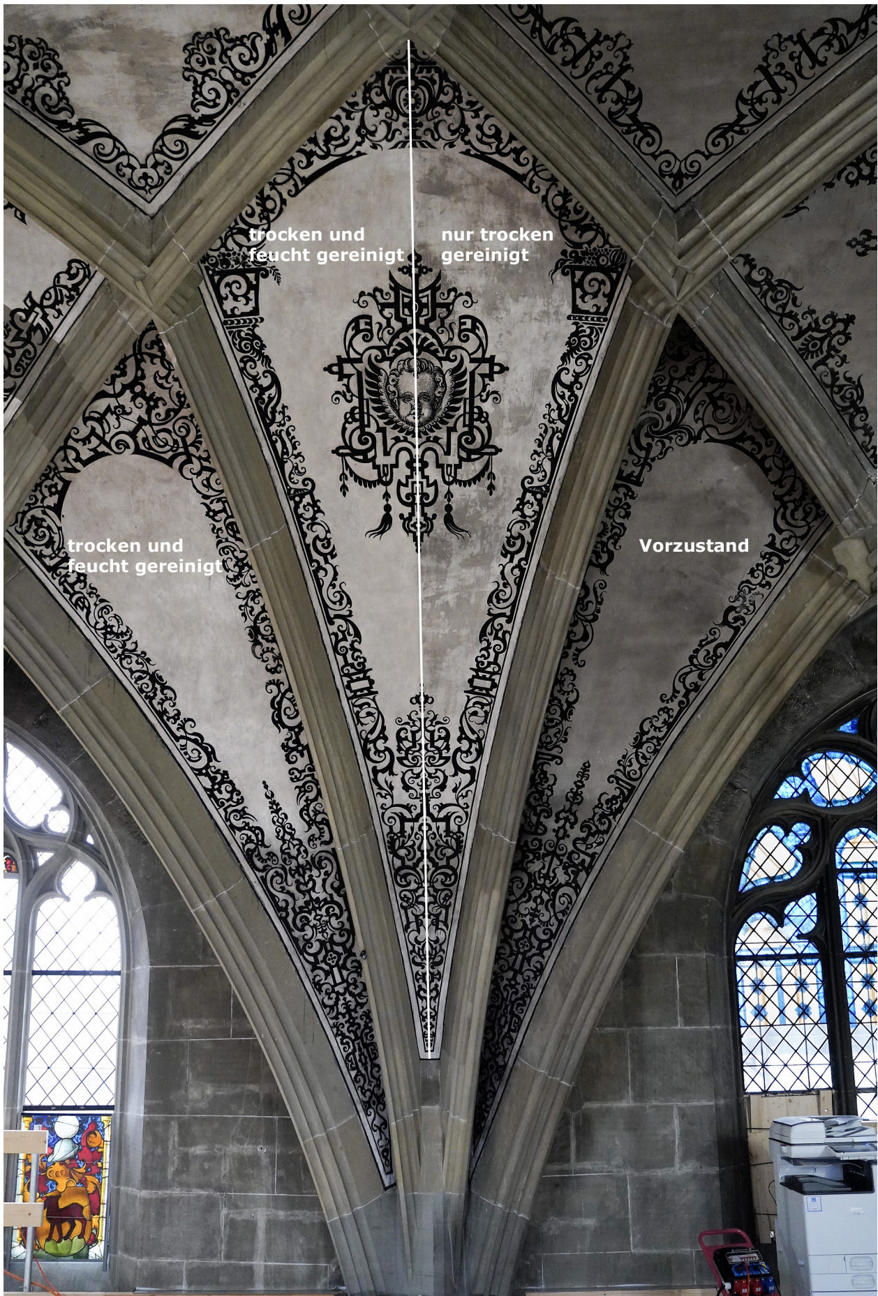
02: Referenzkappen (050-060.230) in unterschiedlichen Reinigungsstufen. Links trocken und feucht gereinigt; Mitte: linke Hälfte trocken und feucht gereinigt, rechte Hälfte nur trocken gereinigt; rechts: nicht gereinigt. Foto: Berner Münster-Stiftung, Bern
