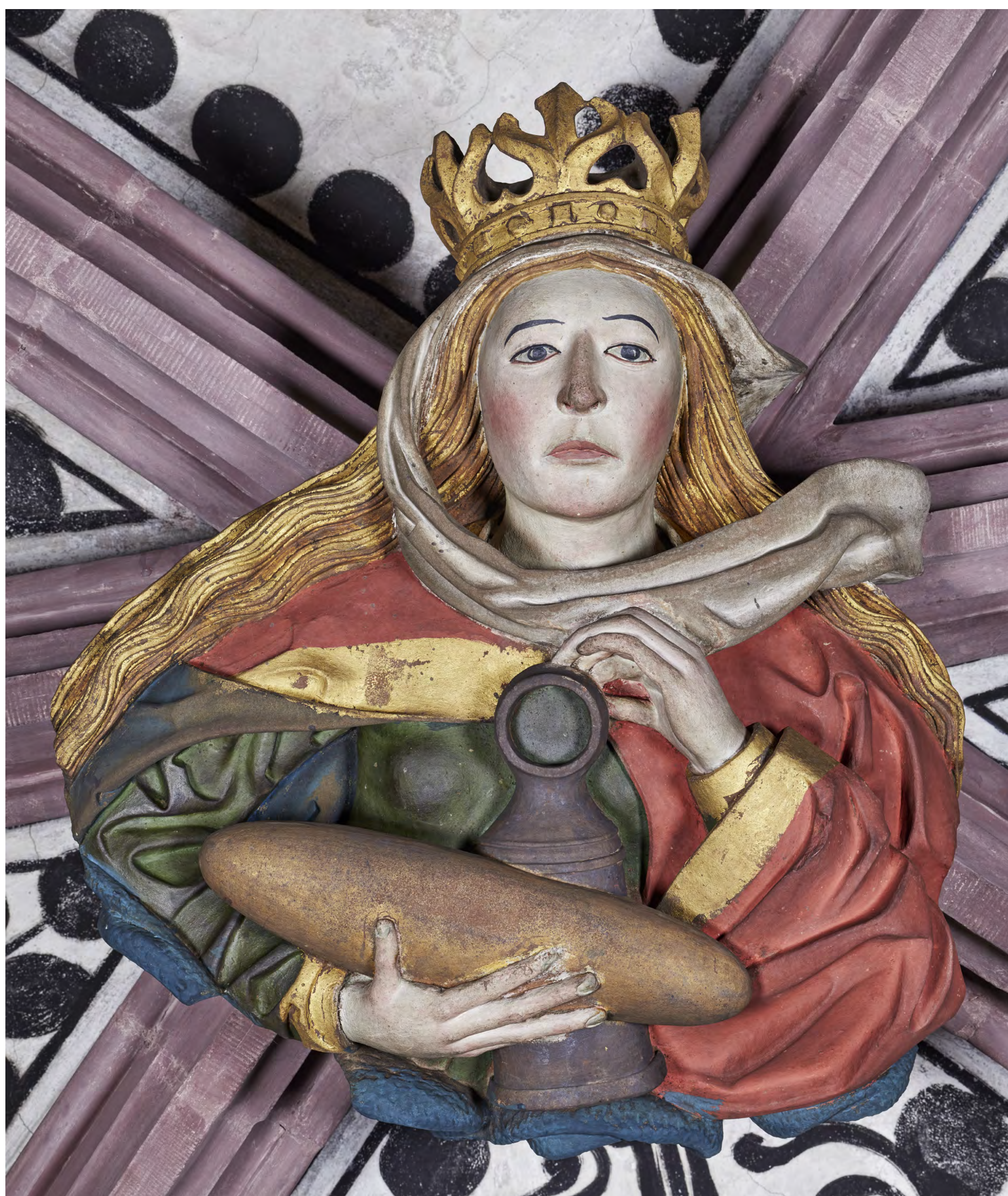
Nr. 33 - Elisabeth, Schlusszustand 2017 Beim Einbau der Schlusssteine zeigte sich, dass der Abstand zwischen Skulptur und Rippenanschluss oft zu klein war, um den Stein auf das Lehrgerüst abzusetzen. Das Problem wurde kurzerhand gelöst, in dem man einfach ein Stück der Skulptur abschlug, danach hatte das Stützholz wieder Platz. Die Fehlstellen wurden später einfach mit Farbe überstrichen.
