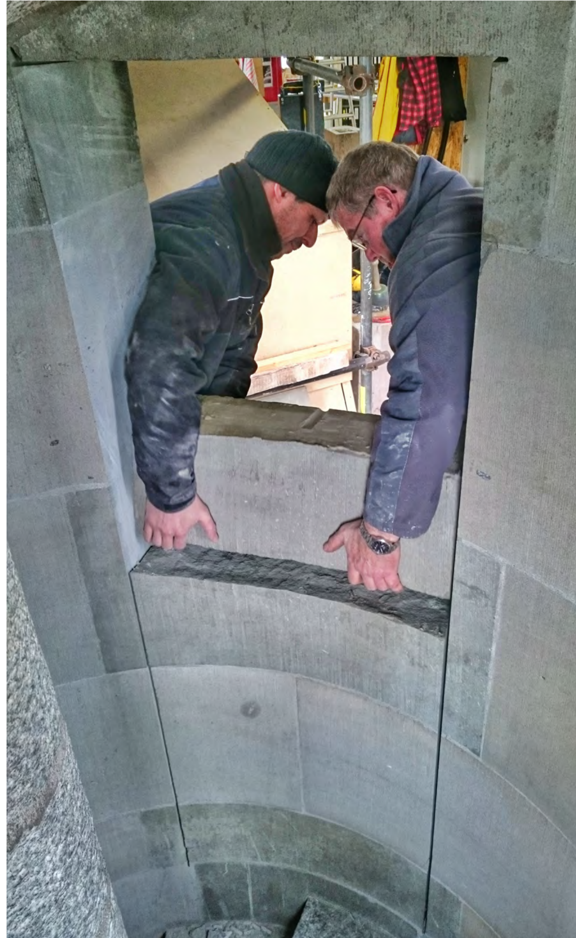
Neuer Zugang von der Turmhalle ins Treppentürmchen.
