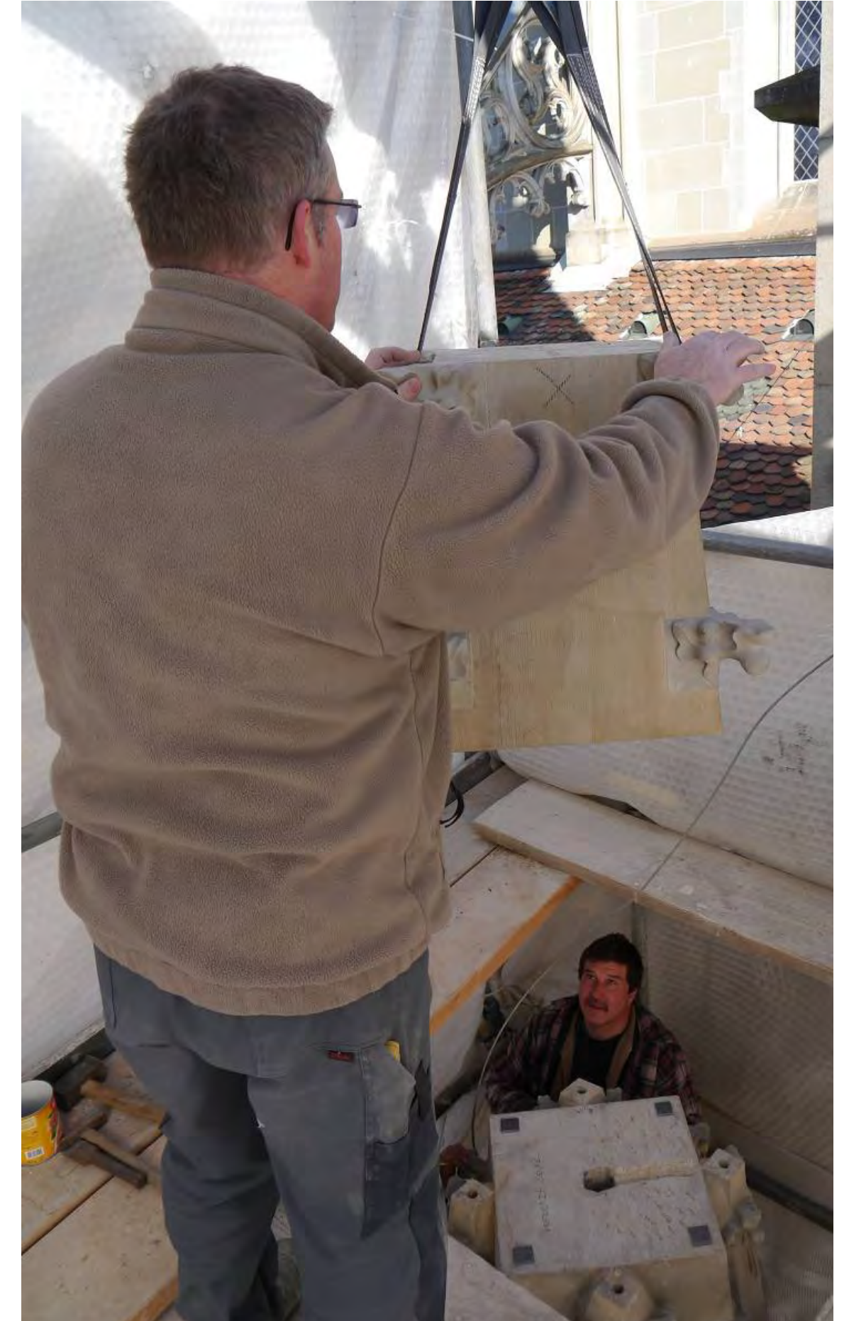
Neu Versetzen einer Fiale.
