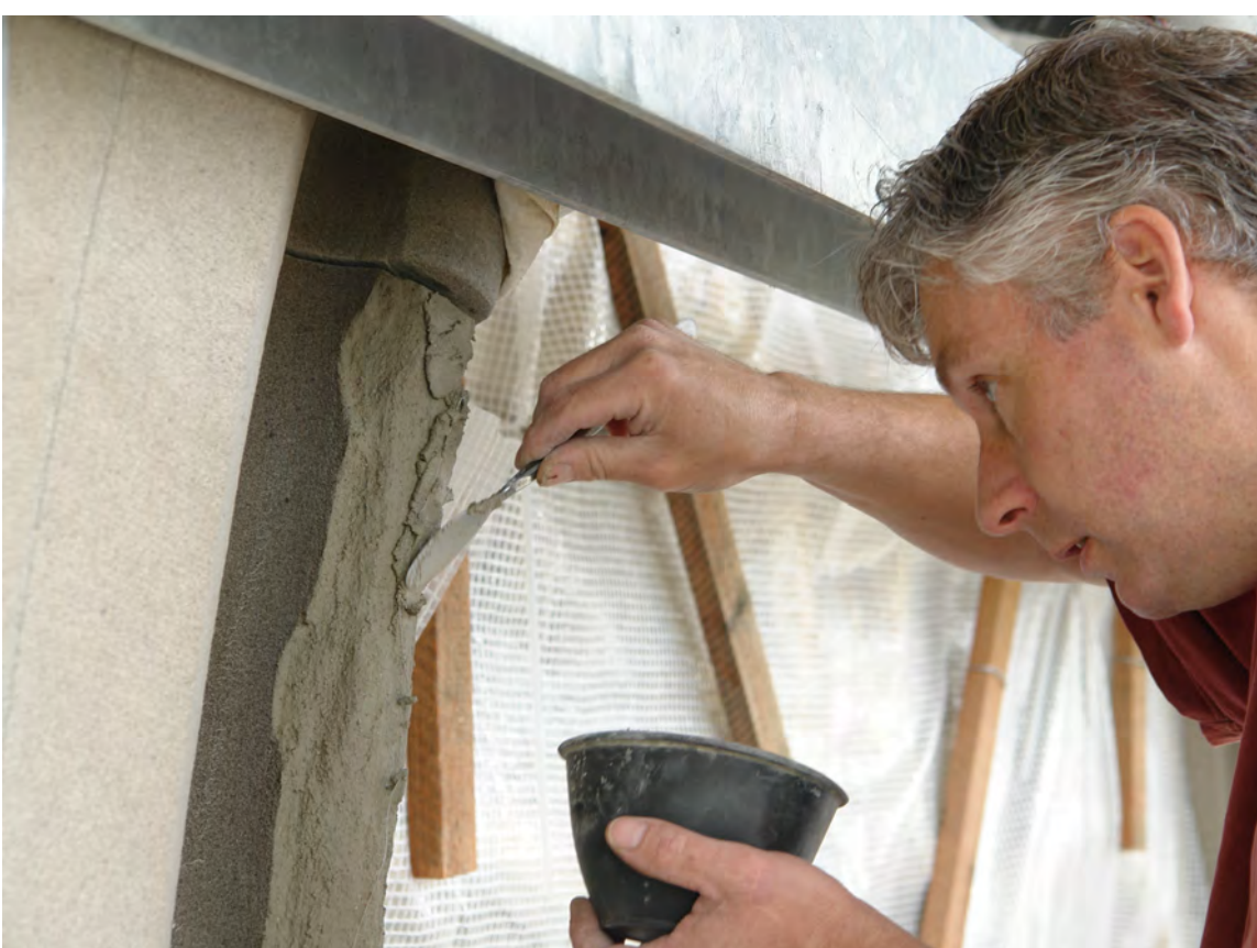
Aufmörtelung statt Steinaustausch.
