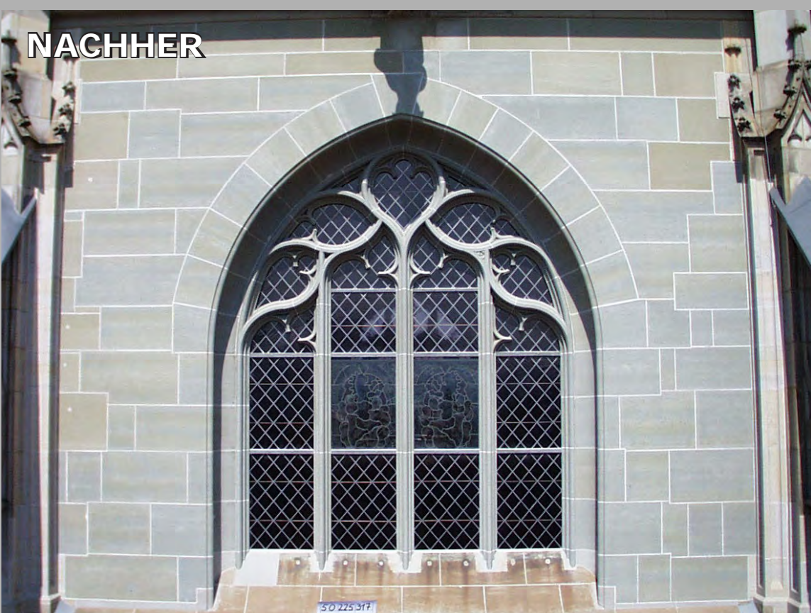
Nach dem Neubau: rekonstruiert, idealisiert, Baugeschichte nicht mehr ablesbar.
