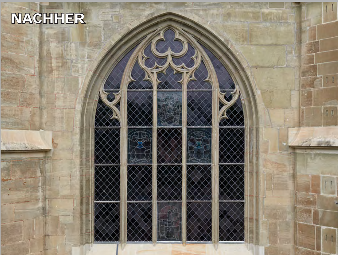
Seitenschiff Feld 70 Süd nach der Konservierung / Restaurierung in situ (ohne jeglichen Steinaustausch).
