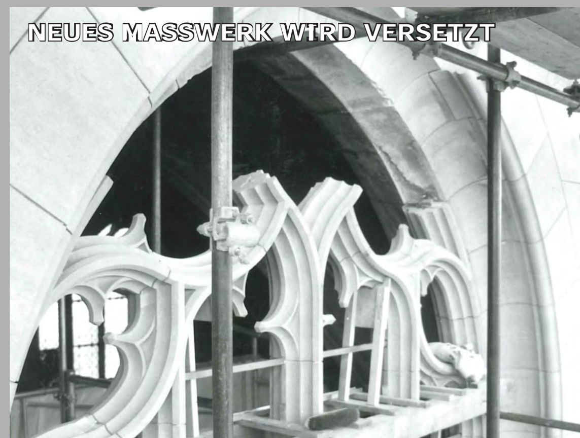
Neue Kopie des Fenstermasswerkes wird eingesetzt.
