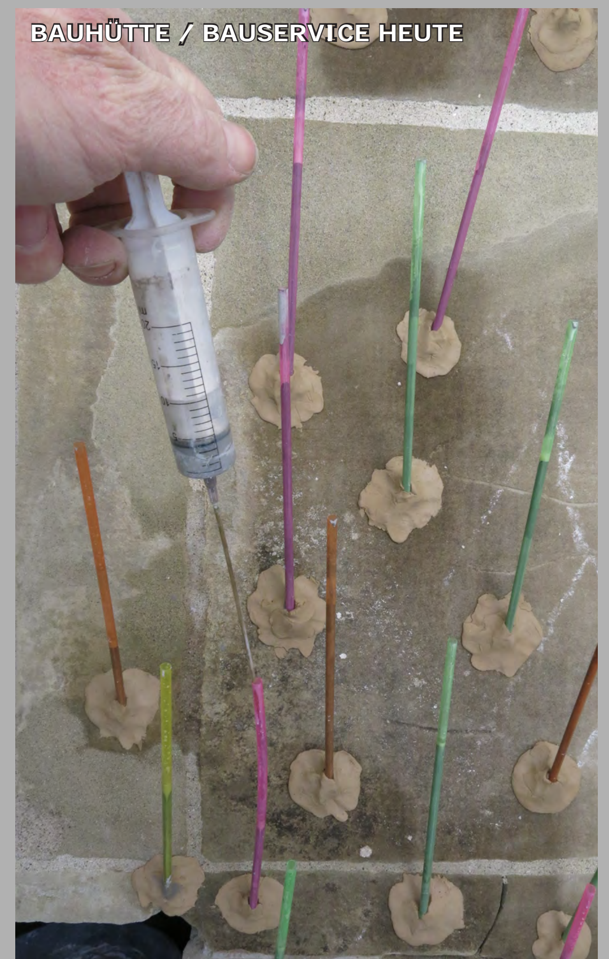
Zusätzliche Kompetenzen in der Steinkonservierung (im Bild: Hintergiessen von Hohlstellen an einem Fenstermasswerk am Turm- oktogon).
