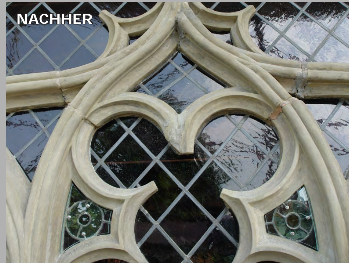
Seitenschiff Feld 50 Südseite - Masswerk mit Steingergängsmörtel repariert.
