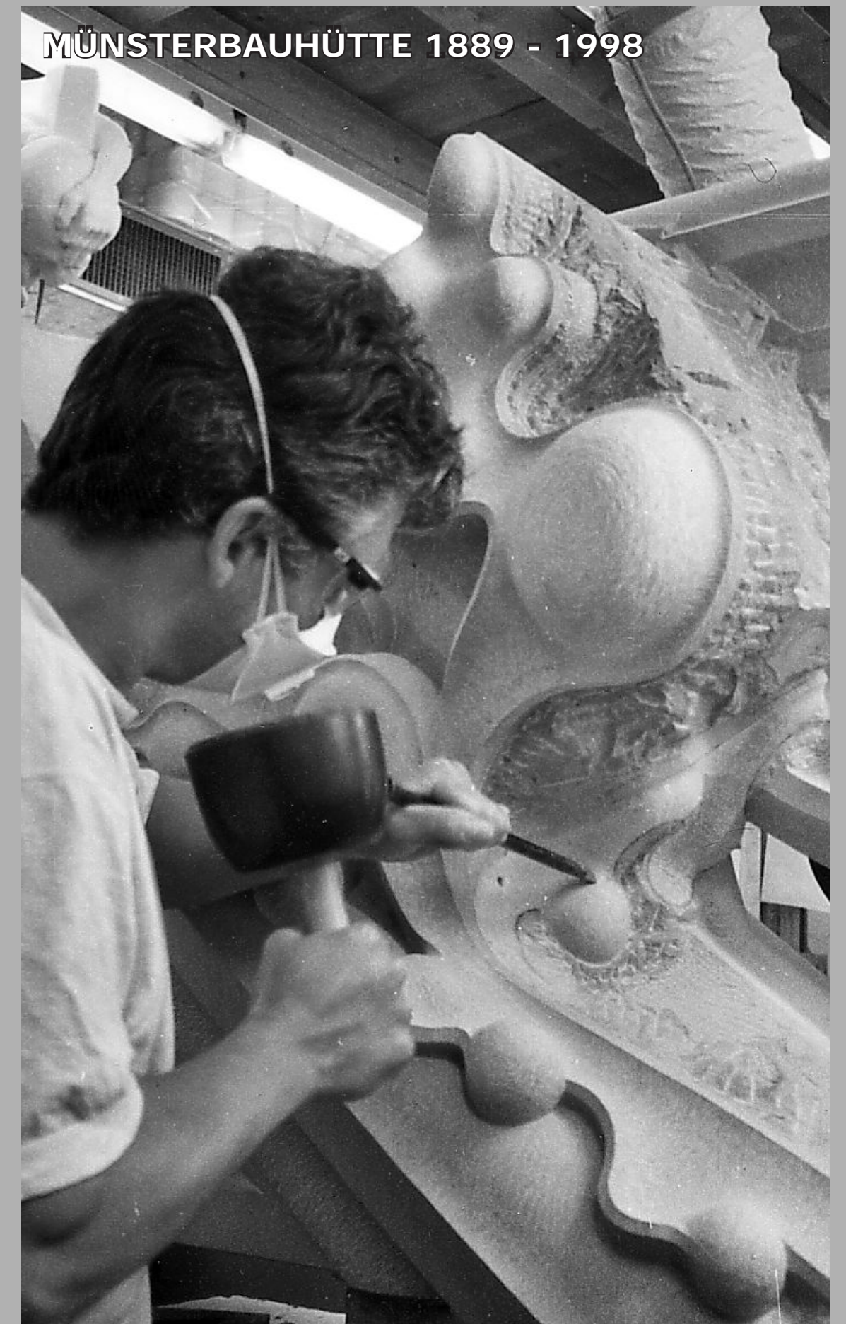
Anfertigung von neuen Werkstücken als einzige Massnahme.
