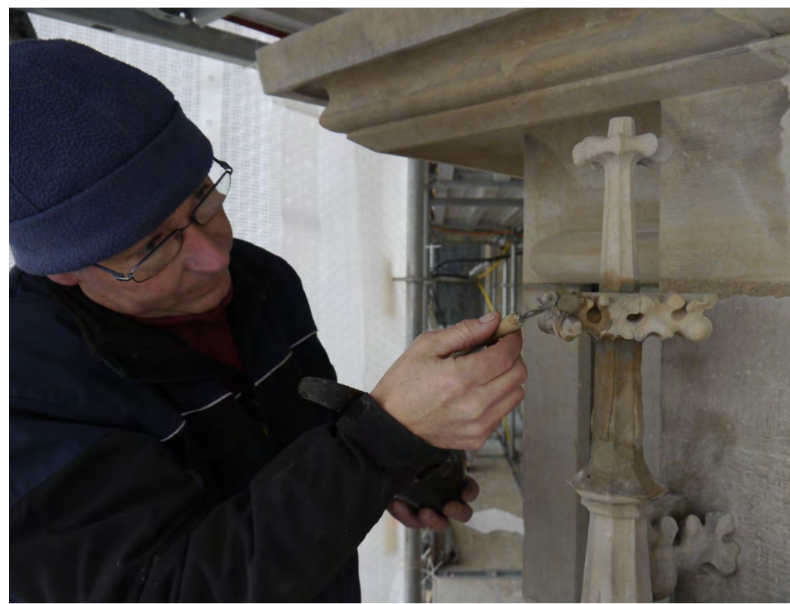
Aufmörtelung statt Steinaustausch.
