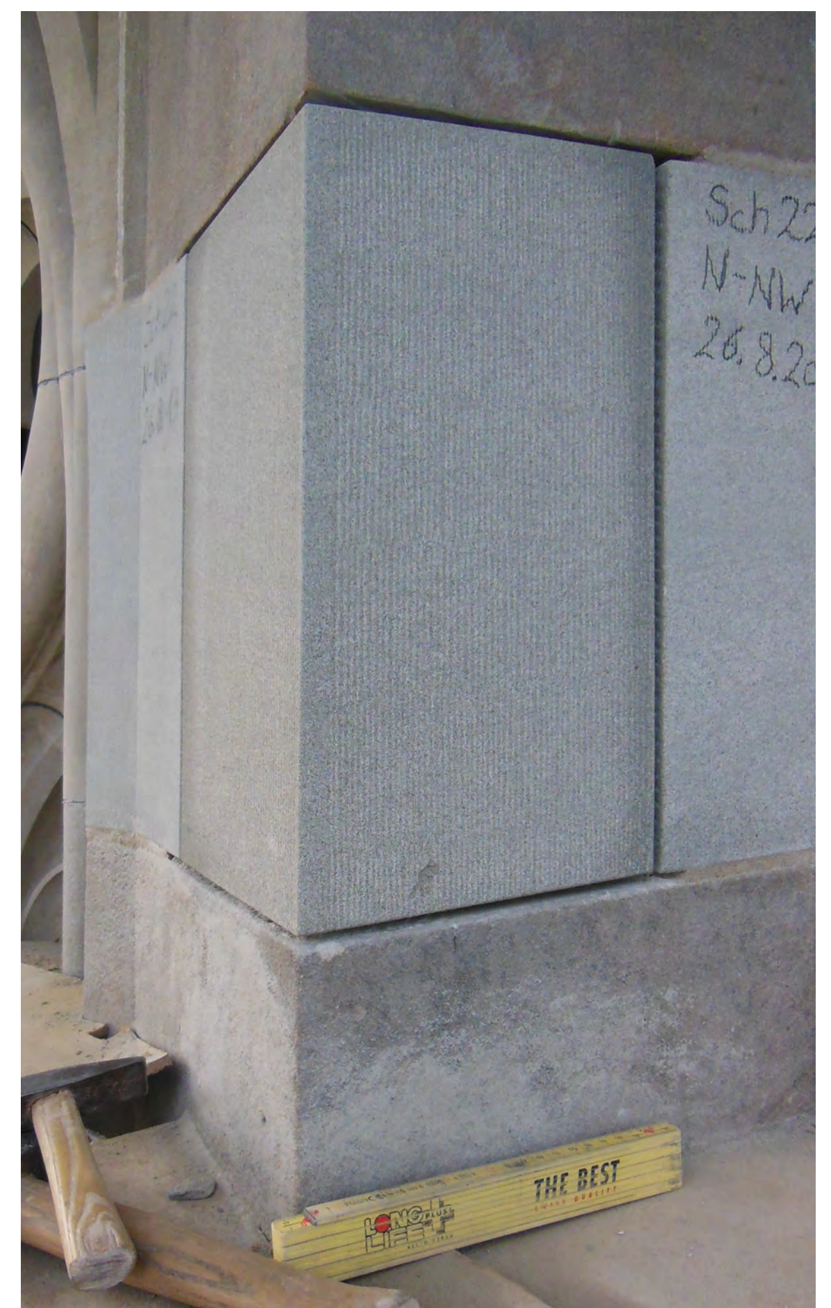
Einsetzen der neuen Vierung.
