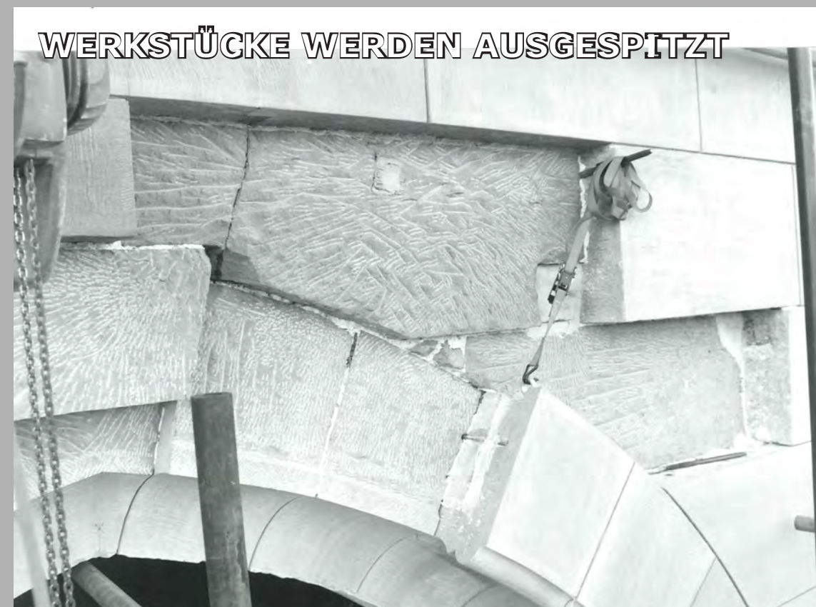
Steinaustausch und massives Zurückarbeiten der Werkstücke an den Wandflächen.
