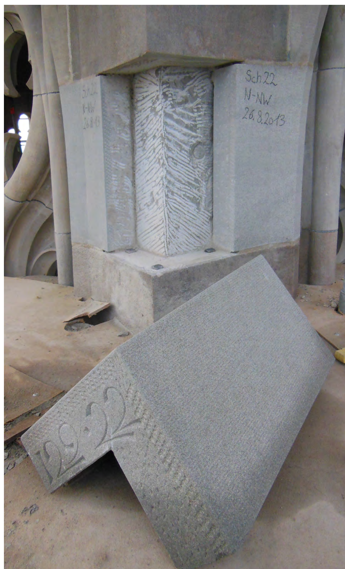
Vierung aus Bollinger Sandstein.
