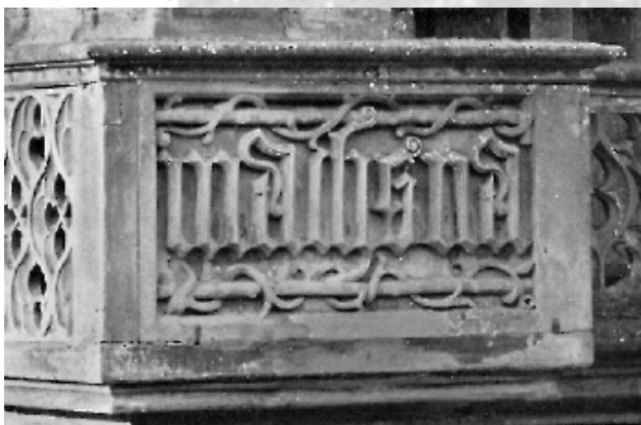
Galeriebrüstung vor der Stirnseite des Pfeilers östlich der Schultheissenpforte, Inschrift „machs na“. Um 1500
