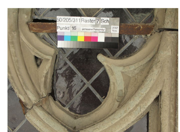
Detail 16: Ein bautechnisches Kuriosum. Die linke Masswerkknase wurde zurückgearbeitet, wohl um die Verschiebung in der Masswerkgeometrie zu kaschieren?
