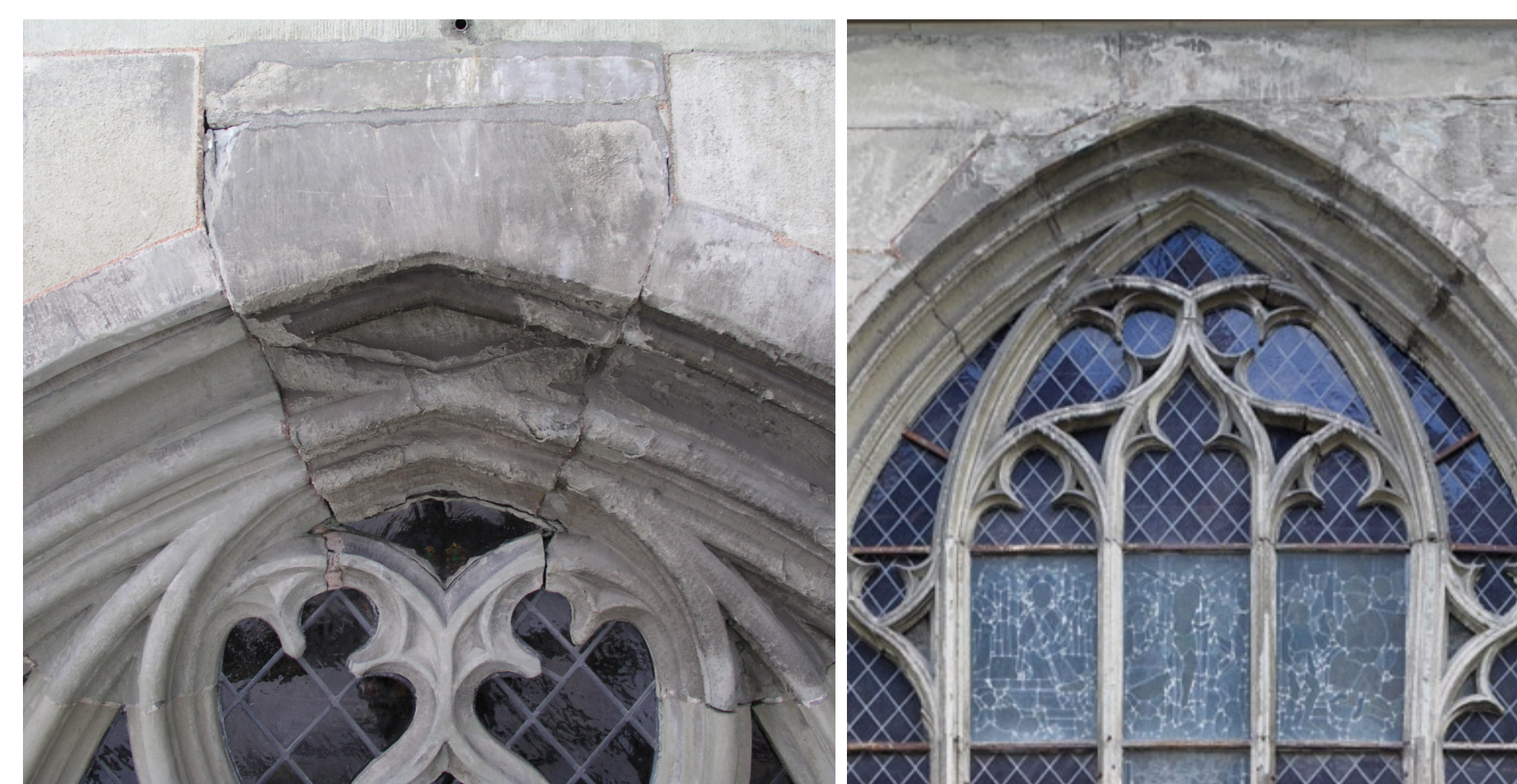
Obt sind an Schlusssteinen von originalen Fenstermasswerken die Bauprobleme, die begrenzten Mittel sowie Stresssituationen aus dem Mittelalter zu erahnen. links: Fenster der Bubenberg-Kapelle (90/245/311), Setzung asymmetrisch während der Bauzeit? rechts: Fenster der Krauchthal-Kapelle (70/255/311), deutliche Asymmetrie im Schlusssteinbereich
