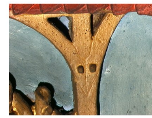
Abb. 24 Detail der Balkenkonstruktion am von Gurtenfry-Wappen
