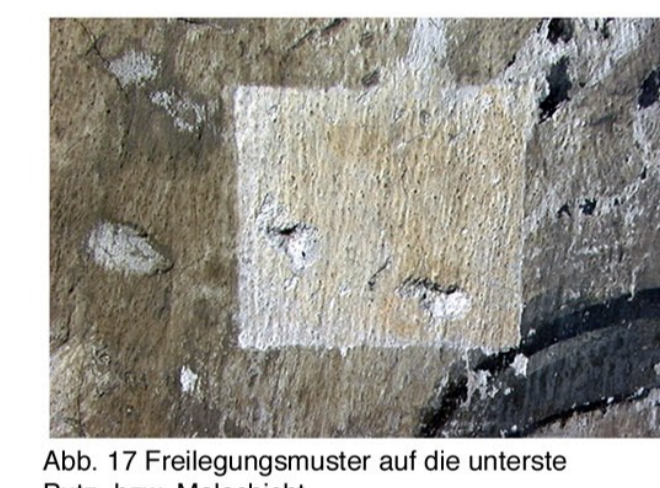
Abb. 17 Freilegungsmuster auf die unterste Putz- bzw. Malschicht
