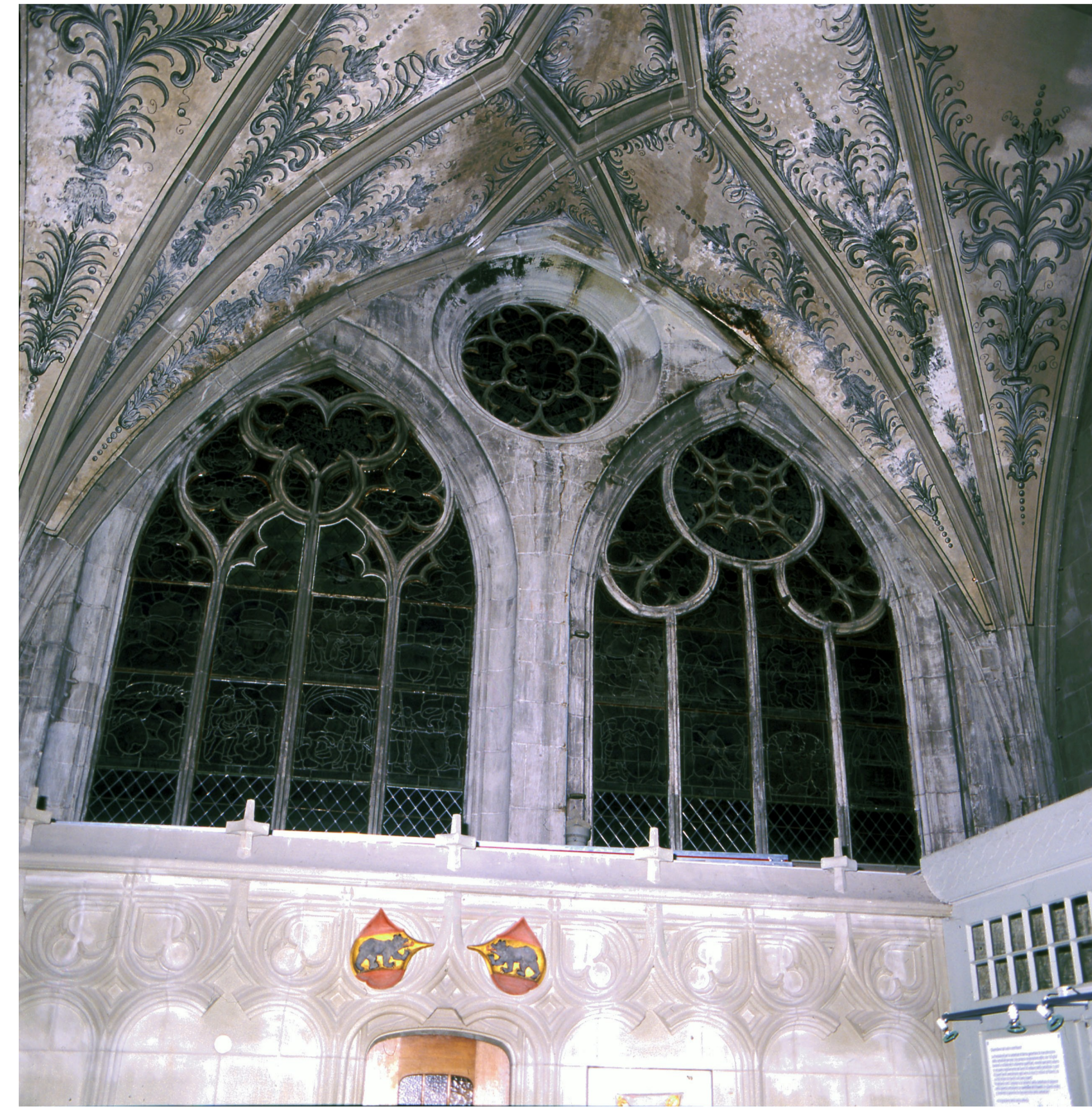
Gewölbe Erlach-Ligerz Kapelle vor und nach der Restaurierung 2004/2005 (Fotos: Urs Zumbrunn).
