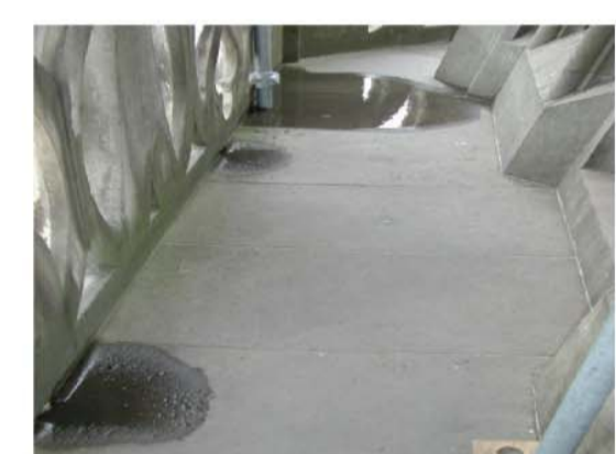
Wasser in den Besuchergalerien verursacht Schäden in den darunterliegenden Gewölben.
