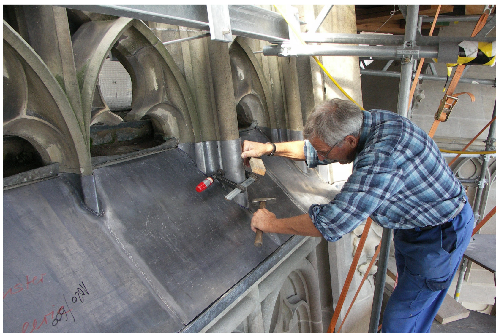
Verbesserung der Wasserführung am Übergang vom Helmstrebewerk zum Turmwächtergeschoss.
