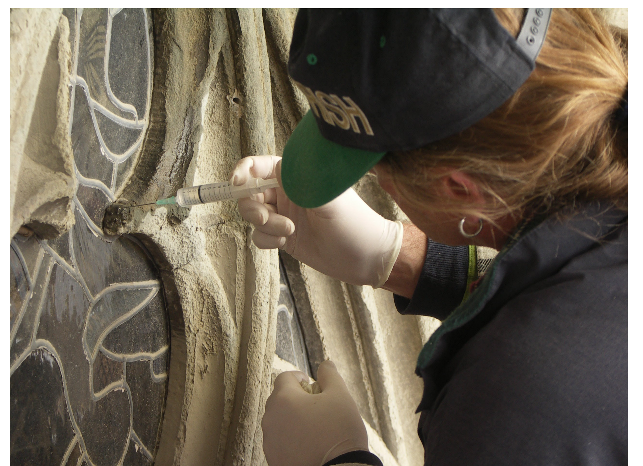
In vielen Bereichen ist nur eine partielle Festigung nötig, vor allem um den Untergrund für nachfolgende Aufmörtelungen zu stabilisieren.
