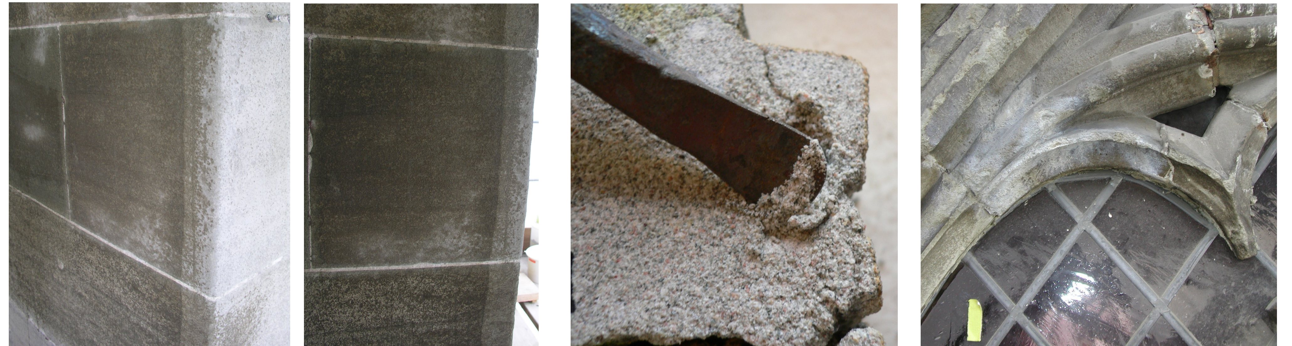
2002: unterschiedliche Gebinde des gleichen Produktes mit unterschiedlichem Verhalten (Pfeiler 35 Nord, Übergang an Steinkante; ein Teil des Produktes bleibt lange hydrofob).
