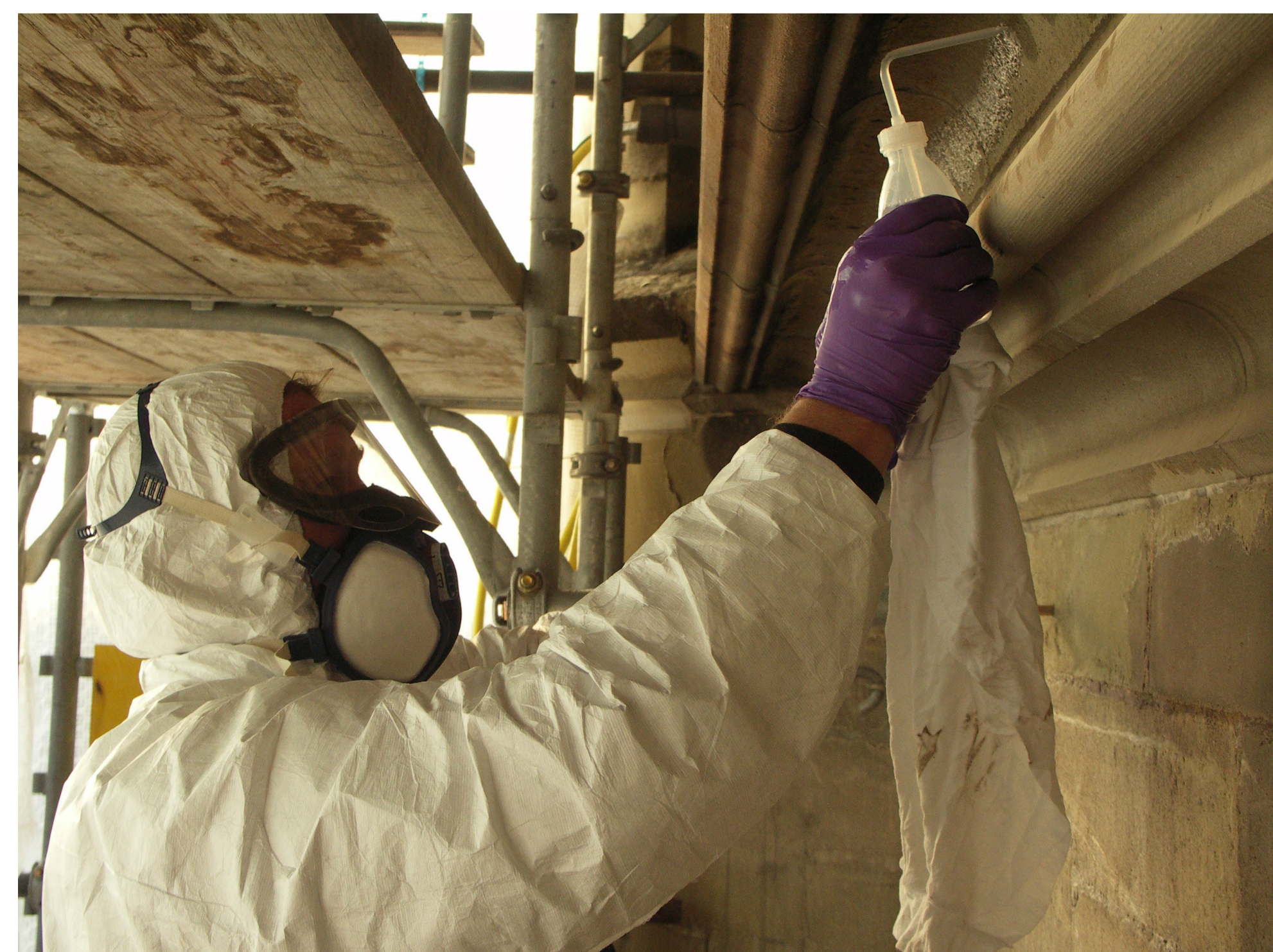
Anwendung am Bau: Flächig absandende Bereiche werden mittels Spritzflaschen behandelt, der Verbrauch liegt bei 1 – 1,5 l/m 2 .
