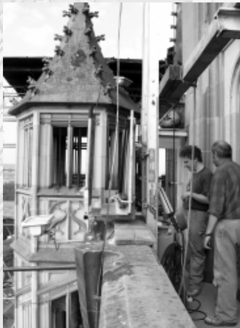
Rechts: Gerüstkonsolen montagebereit
