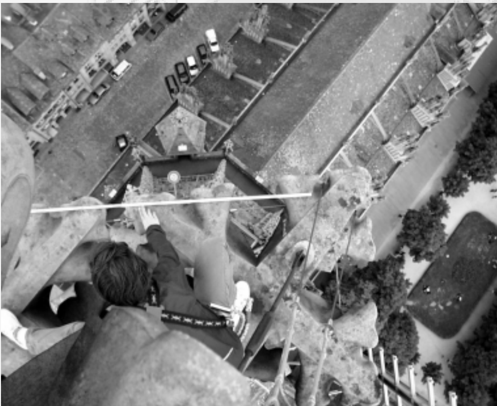
Massüberprüfung an der grossen Kreuzblume zwecks Optimierung/Positionierung des Arbeitsgerüsts
