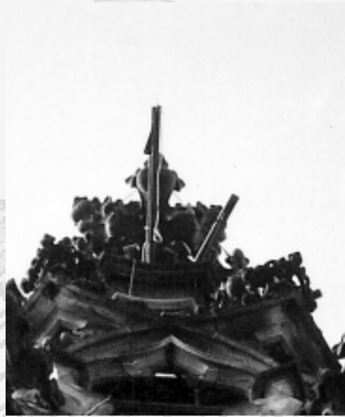
Links: Montage Gerüstboden
