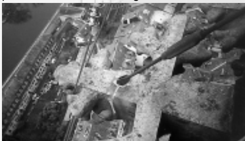
Aufhängung 1946 Zugstab angerostet mit provisorischer Sicherung
