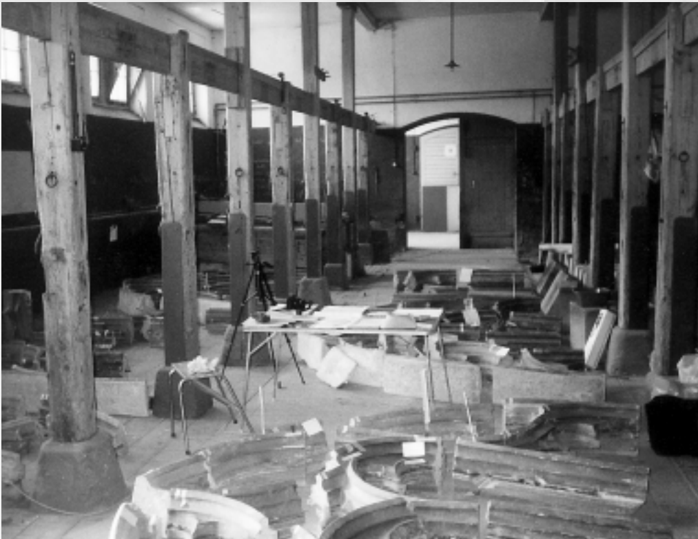
Masswerke vor Abtransport und Einlagerung im Depot Aegerten
