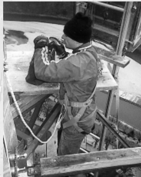
Links: Dokumentation Rechts: Abbau Gerüst
