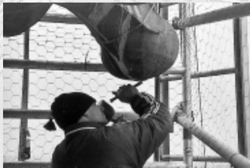
Vorbereitung der Auflager für die Zugstangen
