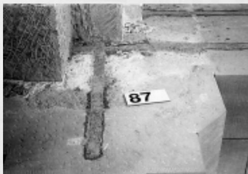
Mauerwerksarmierung eingemörtelt
