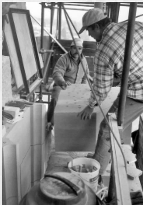
Versetzarbeiten Süd- West Turmeckpfeiler
