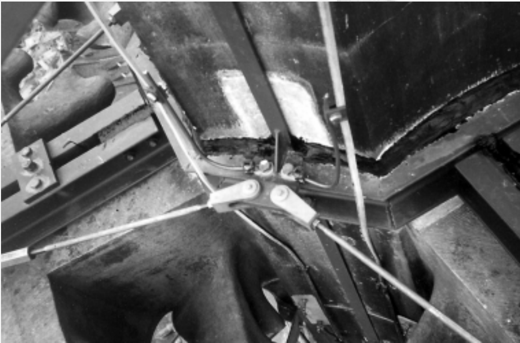
Untere Sicherungsmanschette abgedichtet. Gut sichtbar horizontale Aussteifung
