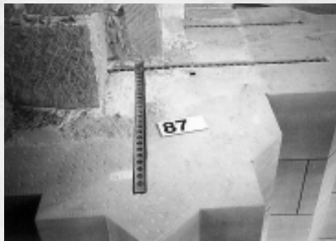
Mauerwerksarmierung eingefräst
