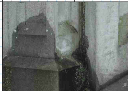
Wasser von oben ... Durch ständig herablaufendes Wasser entstandene Auswaschungszone mit Erosionserscheinungen und Schmutzkruste.
