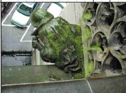
Chronische Schwachpunkte Aus der Fläche herausragende Simse, Frieze oder andere Ornamenteile mit darunter sporadisch durchfeuchteten Schadstoff- und Salzansammlungszone.
