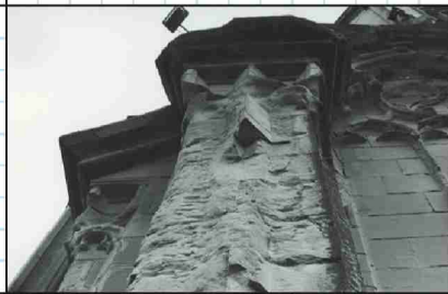
Extreme Verwitterung Stark verwitterte Turmfassade West gross- teils bereits 1849 schon einmal erneuert!
