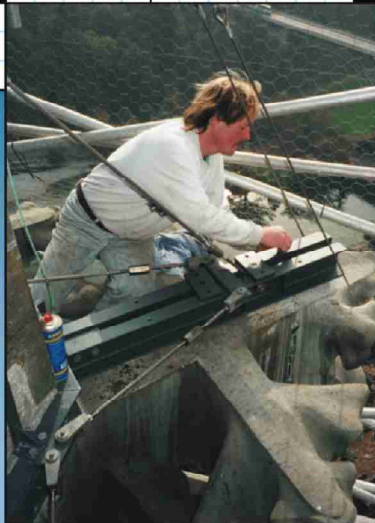
Sicherheit Montage Sicherungsmanschette + Zug- stangen an Turmhelmspitze hoch über dem Münsterplatz
