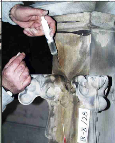
Konservieren Injektion mit Acrylharz, Verschluss von Rissen
