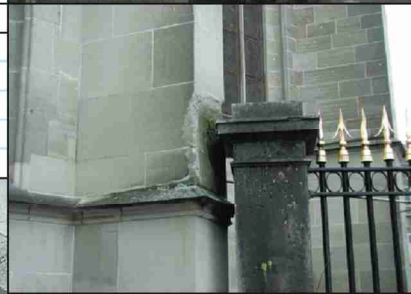
... und von unten Spritzwasser und aufsteigende Mauerfeuchte führen im Sockelbereich zu verschiedenen Schadensbildern: Verätzung, hygroskopische Flecken, Schalenbildungen, Salzausblühungen und Aushöhlung.
