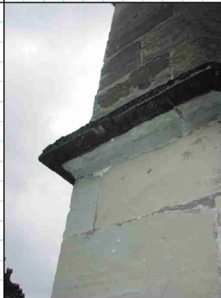
Chronische Schwachpunkte Aus der Fläche herausragende Simse, Frieze oder andere Ornamenteile mit darunter sporadisch durchfeuchteten Schadstoff- und Salzansammlungszone.
