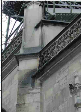
Wasser von oben ... Durch ständig herablaufendes Wasser entstandene Auswaschungszone mit Erosionserscheinungen und Schmutzkruste.
