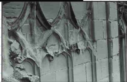
Extreme Verwitterung Stark verwitterte Turmfassade West gross- teils bereits 1849 schon einmal erneuert!
