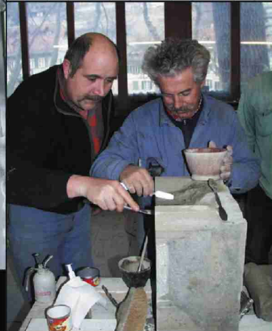
Restaurieren Aufmörtelung schadhafter Stellen am Stein
