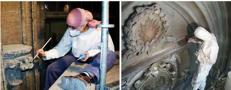
Spezielle Aufmerksamkeit wurde dem Tympanon am Nordportal Ost gewidmet. Das durch Taubenkot stark verschmutzte Relief wurde nach der Festigung mittels Mikrosandstrahlen gereinigt und danach durch Restaurator A. Suter sorgfältig konserviert. Lose Teile (Schollen, aufgebrochene Ränder, Schuppen) wurden zurück geklebt und die Lesbarkeit der Formen mit wenigen Ergänzungen und Stützkittungen wiederhergestellt.
