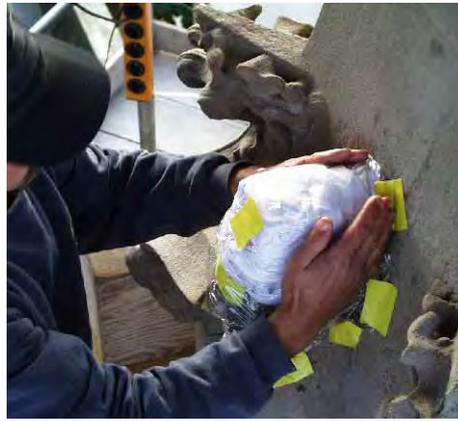
Zum Schluss wurden die Mörtelflicke wie auch die wenigen mit Naturstein ersetzten Teile mit Mineralfarbe farblich auf die Umgebung abgestimmt. Ähnlich wurde bis vor kurzem auch zum Angleichen von neuem Oberkirchener Sandstein an Berner Sandstein verfahren. Mit der Zeit werden bei möglichst gleicher Oberflächenbeschaffenheit sowohl Mörtelflicke wie auch die Natursteine wieder eine ähnliche Patina ansetzen und von unten auch ohne „Kosmetik“ nicht mehr voneinander zu unterscheiden sein.
