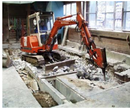
Ausbrechen der alten Fundamentplatte
