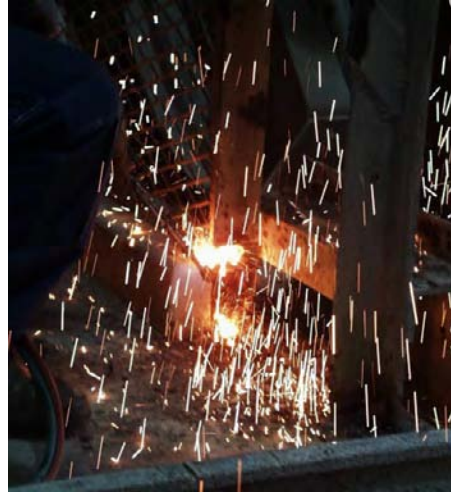
Ausbau der alten Säge in der Münsterbauhütte
