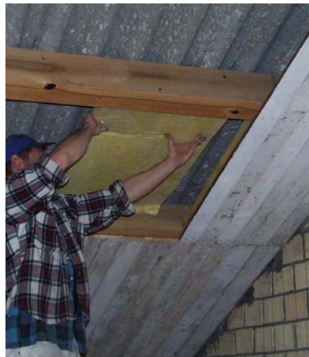
Isolieren des Dachs über der ehemaligen Garage
