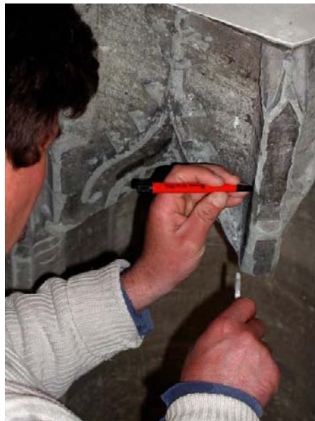
Reinigung der Konsolen und Baldachine mittels Glasfaserpinsel.
