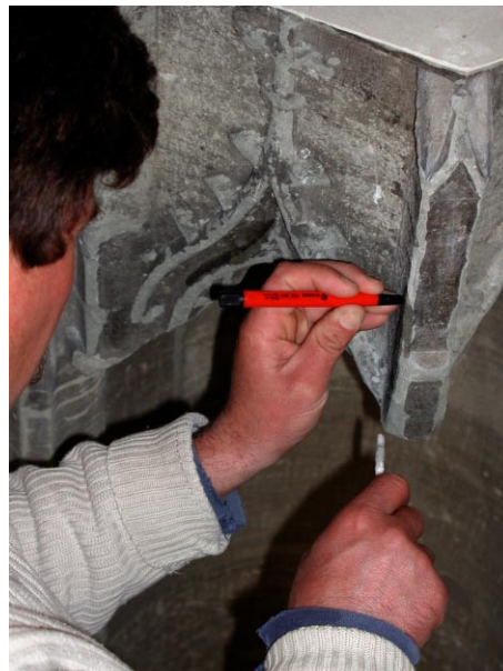
Reinigung der Konsolen und Baldachine mittels Glasfaserpinsel.
