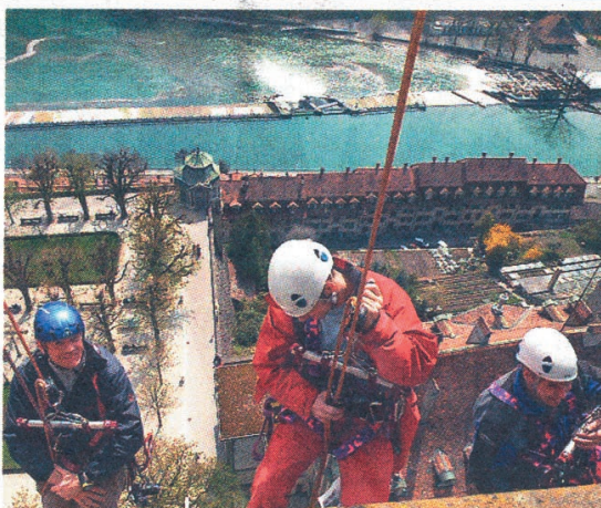
Unter Aufsicht eines Bergführers wird die Turmfassade kontrolliert. meo
