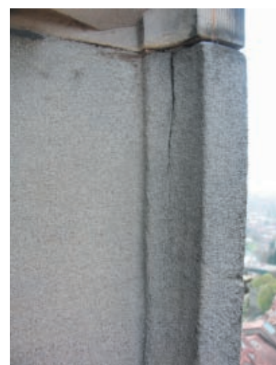
oben: Die Mischbauweise mit unterschiedlich hartem Sandstein führt zu Schäden, hier am oberen Turmachteck.
