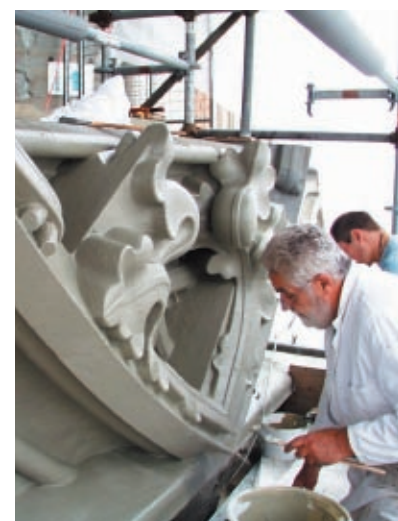
oben: Anbringen des Schutzanstriches mit Ölfarbe.
