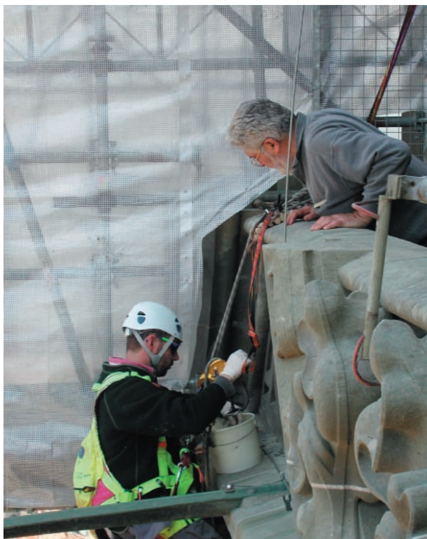
oben: Anbringen des Schutzanstriches mit Ölfarbe.
