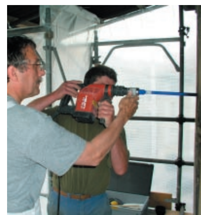
Für die Analyse wird eine Bohrprobe entnommen.
