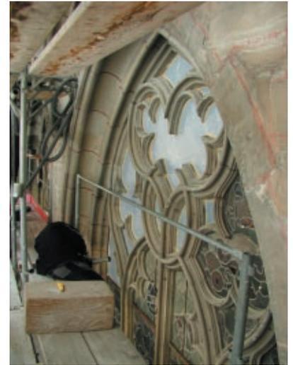
oben: Feuerprobe für die Fotogrammetriepläne: Als Schutz für die Glasmalereien der Erlach-Ligerz-Kapelle wurden die Pläne 1:1 ausgedruckt und aus Schutzfolie ausgeschnitten. Die Schablonen passten millimetergenau!
