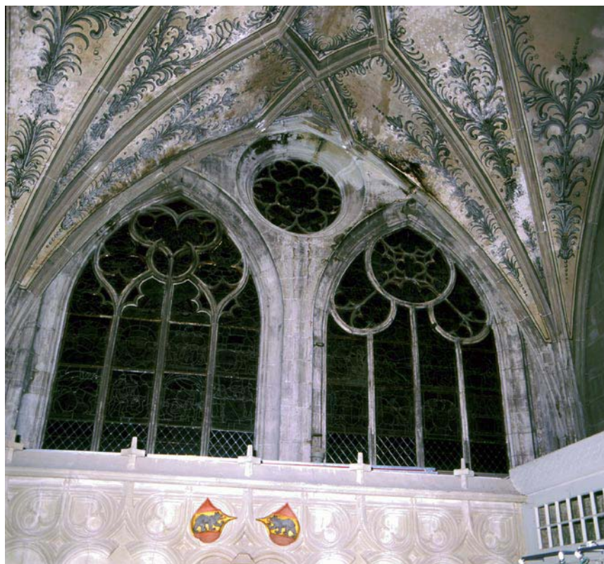
Inneres der Kapelle, Vorzustand im Dezember 2004. Foto: Urs Zumbrunn
