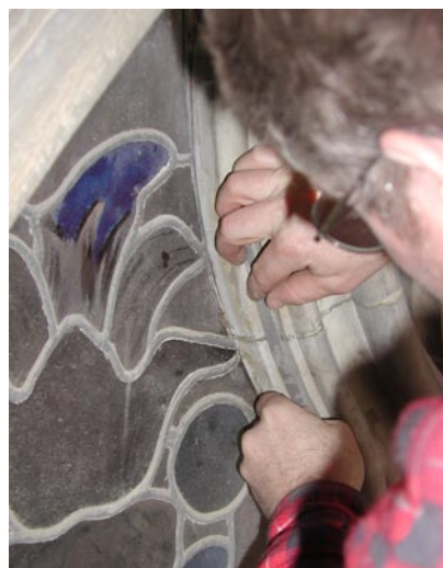
links von oben nach unten: Sicherung der absturzgefährdeten Rosette / Vergiessen von Rissen mit Acrylharz und Edelkalk / Anbringen von filigranen Chromstahlarmlierungen
