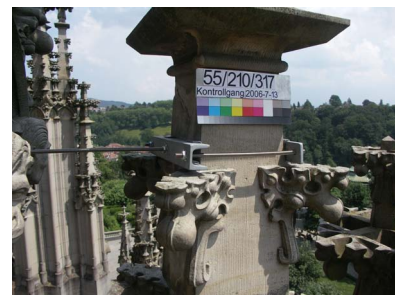
Eine Fiale erhielt eine Sicherungsarmierung aus Gewindestangen und Flachstahl.
