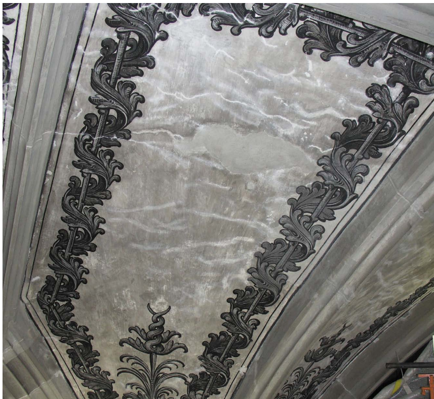
oben: Gewölbekappe, Zwischenzustand nach dem Schliessen der Risse (Foto vom 12.02.2008 / Urs Zumbrunn, Restaurator HFG, Kirchberg)
