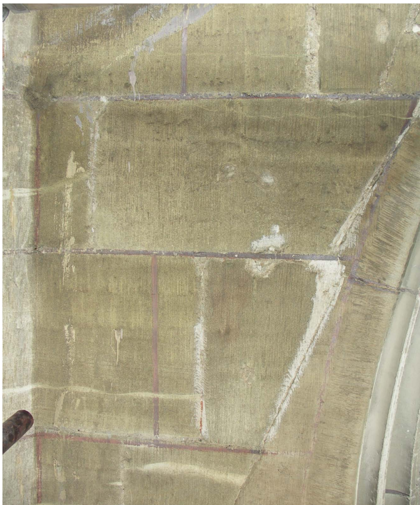
oben: Während dem Festigen der Wandoberfläche waren die gelblichen Farbreste und aufgemalten roten Fugenstriche besonders deutlich sichtbar.
