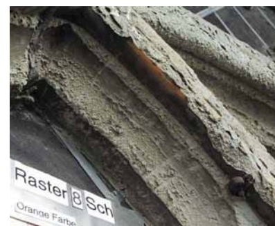
oben: Beispiel von Farbfassungsresten im Fensterprofil
