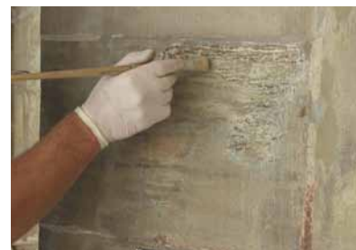
oben: Einretuschieren der Flickstelle mit Silikatkreide und anschliessendes Verwischen mit dem Pinsel
