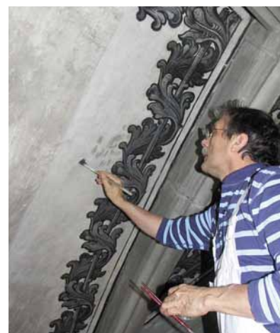
oben: Konservierung und Retuschen an den stark gerissenen Gewölbekappen
