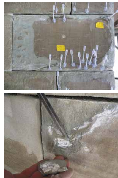
Aufgeklebte Tropfpipetten zum Befüllen mit den Injektionsmaterialien / Abgenommene Schale zur Überprüfung des Verfüllungsgrades und der Klebwirkung
