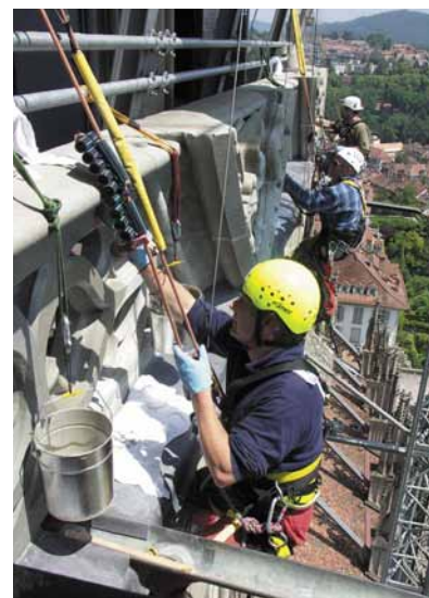
Ölen der Masswerkbrüstung im Seil Aufwändig aber effizient: Die Arbeit konnte in wenigen Tagen durchgeführt werden.
