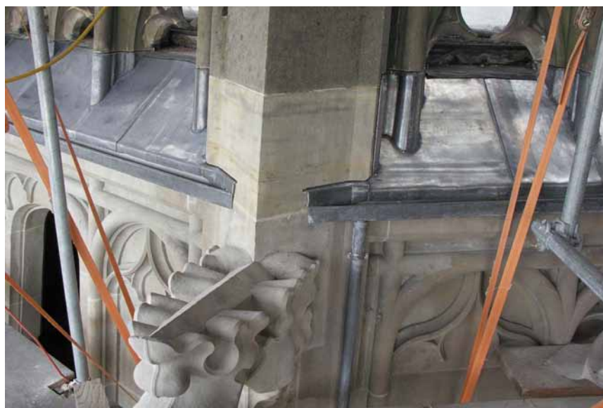
mitte links: Fertige neue Abdeckung und Wasserableitung
