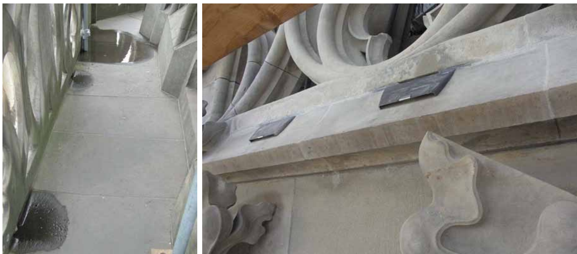
Die alten Ausflussöffnungen der Achteckgalerie wurden von aussen mit Bleilappen abgedeckt. Dank dieser Massnahme kann Kondenswasser und Wasser von innen abfliessen, jedoch kein Regenwasser von aussen eindringen.
