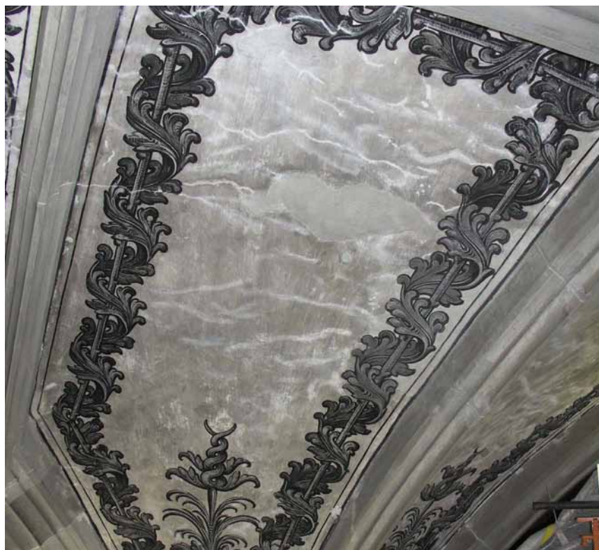
oben: Gewölbekappe, Zwischenzustand nach dem Schliessen der Risse (Foto vom 12.02.2008 / Urs Zumbrunn, Restaurator HFG, Kirchberg)
