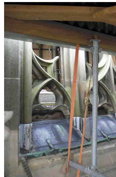
mitte links: Fertige neue Abdeckung und Wasserableitung
