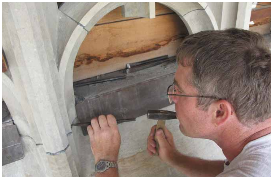
Nachstemmen von offenen Bleifugen am Fenstermasswerk Ost
