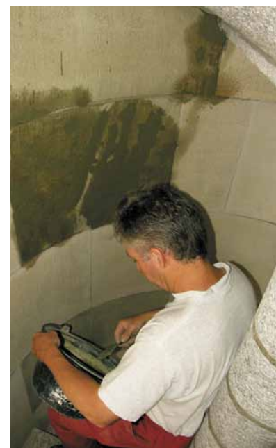
oben: Aufmörtelung von stark beschädigten Wandteilen
