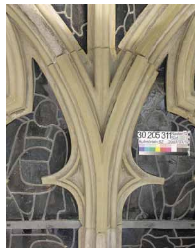
rechts von oben nach unten: Aufmörtelungsmuster am Bogenscheitel vorher / nachher (die definitive Ausbildung der Reprofilierungen erfolgte weniger scharfkantig) / Auftragen des Deckmörtels / Aufgemörteltes Masswerkprofil
