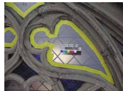
oben: Neues Verfahren für den Glasschutz: Das blaue Spezialband wird direkt auf die Glasoberfläche geklebt. Es dient als Träger für den mit Betonklebeband befestigten Schablonit.
