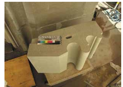
Eine Gewändevierung bereit zum Versetzen
