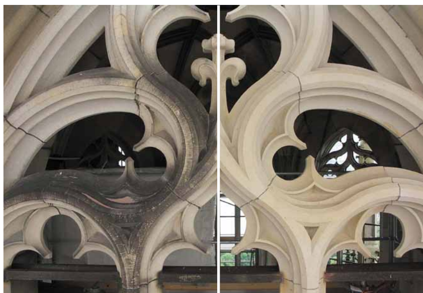
oben: Reinigung des Fenstermasswerks der Achteckhalle (links: vorher-nachher)
