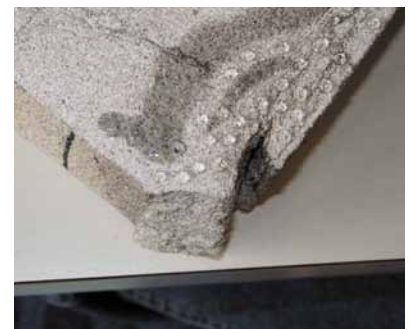
Deutlich erkennbare Hydrophobie in der Randzone eines gefestigten Prüfstückes aus Zuger Sandstein (Foto: CSC Fribourg / 09.02.2007)
