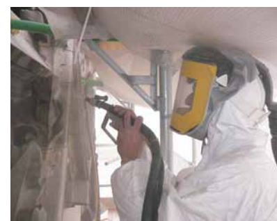
oben: Reinigung des Fenstermasswerks der Achteckhalle (links: vorher-nachher)
