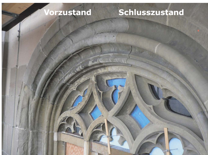
Zur Hälfte restauriertes Masswerk (Vorzeigebjekt für Tagung)
