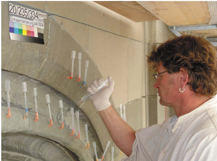
Retaurierung der Risse und Schalen am Fenstermasswerk an der Nordseite
