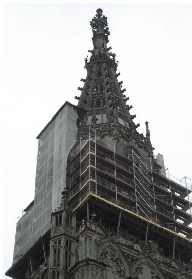
Abbau Ost und Aufbau West
