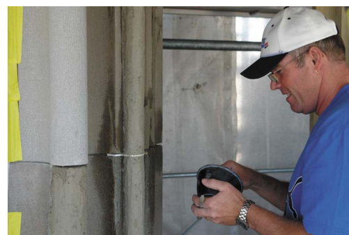
Aufmörteln an der Nordseite
