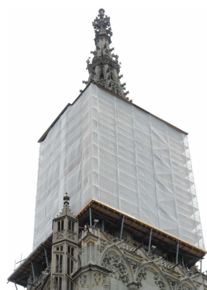
Westseite fertig eingerüstet
