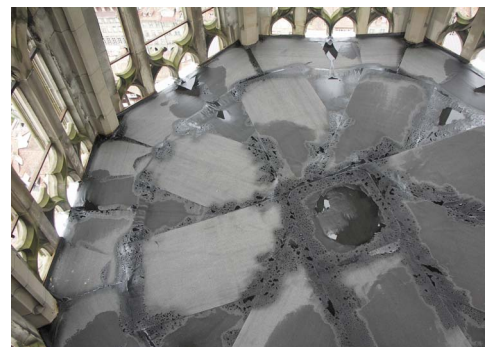
Abdichtung des Schutzdachs im Turmhelm
