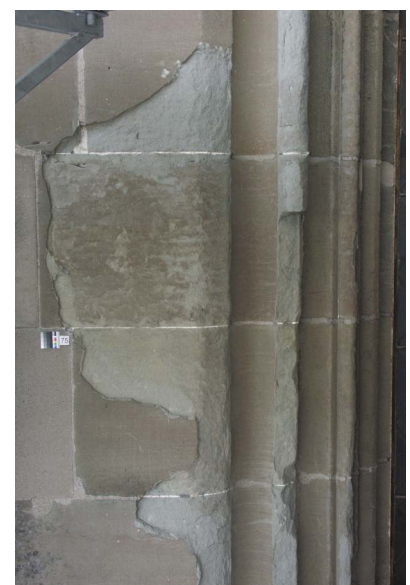
Wandfläche in Berner Sandstein am unteren Achteck West.
