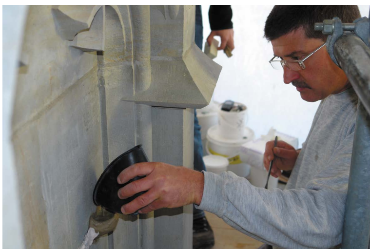
Riss- und Fugensanierung Südwestfiale
