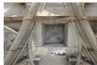
links: Risse und offene Fugen an der Südwest-Ecke des Turmachteckes / rechts oben: Zur Überwachung allfälliger Bewegungen wurden an der Südwest-Ecke Rissmarken gesetzt / rechts unten: Sondierung an der vermuteten Position des Ringankers unter der obersten Besuchergalerie
