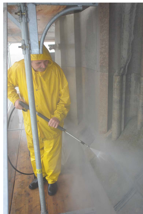
Nassreinigung am oberen Achteck
