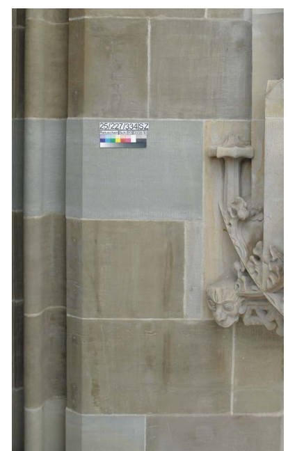
Gleicher Bereich wie oben nach den Finisarbeiten wie Ausfugen und Retuschen mit Silikatcreiden
