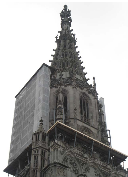
Gerüstbasis West erstellt
