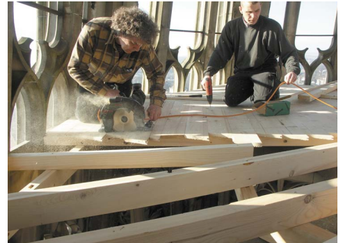
Zimmermannsarbeit auf Mass
