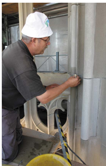
Ausfugen nach dem Versetzen und Aufmörteln
