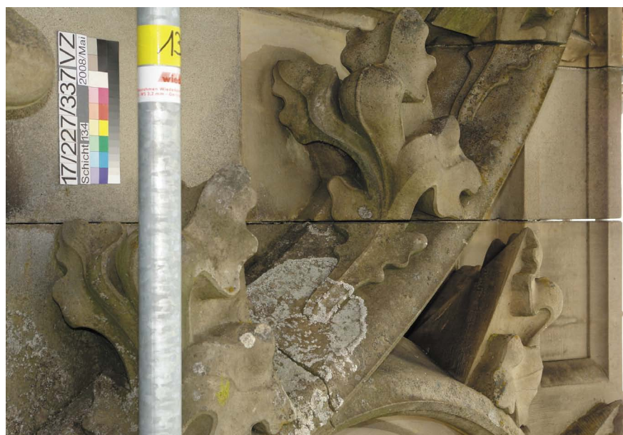
links: Risse und offene Fugen an der Südwest-Ecke des Turmachteckes / rechts oben: Zur Überwachung allfälliger Bewegungen wurden an der Südwest-Ecke Rissmarken gesetzt / rechts unten: Sondierung an der vermuteten Position des Ringankers unter der obersten Besuchergalerie
