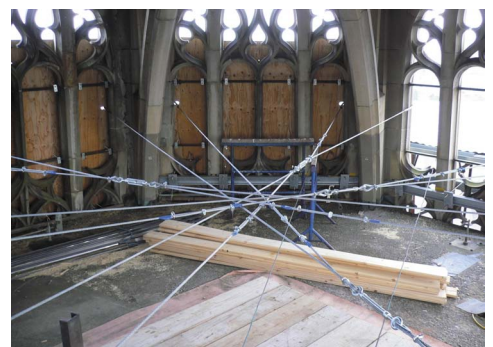
Spannseile zwischen den Helmrippen als Sicherung vor dem Abbruch der darunterliegenden Stahlbetonkappen
