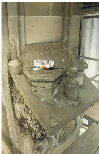
Angetroffener Zustand der Konsole am Pfeiler 115
