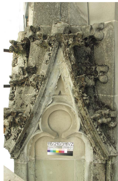
Angetroffener Zustand des Wimperges am Pfeiler 115
