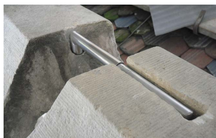
links: Aufmörteln der Brüstung / mitte oben: Vorzustand, Riss am Handlauf der Brüstung / mitte unten: Einbau der beweglichen Befestigungsklammer / oben: Einbleiben der Befestigungsklammer am Handlauf der Brüstung
