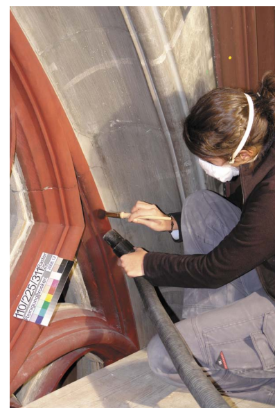
Behutsame Reinigung der bemalten Steinoberfläche
