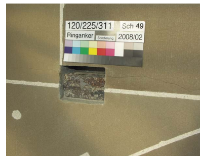
links: Schadenskartierung Christusfenster (vorwiegend absandende Oberflächen), mit Position der Sondierung über dem Fensterscheitel zur Freilegung des Ringankers von 1777 (unten, rechts).
