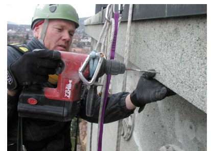
Bohren von Armierungen
