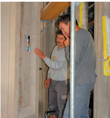
links: Begutachtung von braunen Verfärbungen, welche im Zuge der Restaurierungsarbeiten bei Aufmörtelungen an der Eckfiale Südwest aufgetreten sind. Vermutlich wurden im Stein vorhandene Metalloxide reaktiviert und an die Oberfläche gebracht. Zur oberflächlichen Entfernung der Verfärbungen wurden Versuche mit verschiedenen konventionellen und unkonventionellen Methoden gemacht (rechts).
