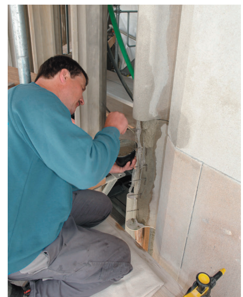
Aufwendige Reparaturen 2009 (oben: mittels Gewändevierungen, unten: mittels Aufmörtelungen).
