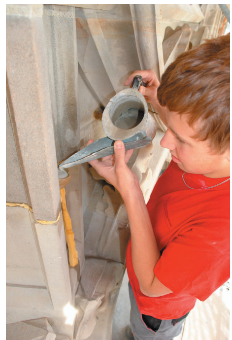
oben: Ausfugen unter der Brüstung. mitte: Vergiessen der offenen Fugen bei Schicht 134.
