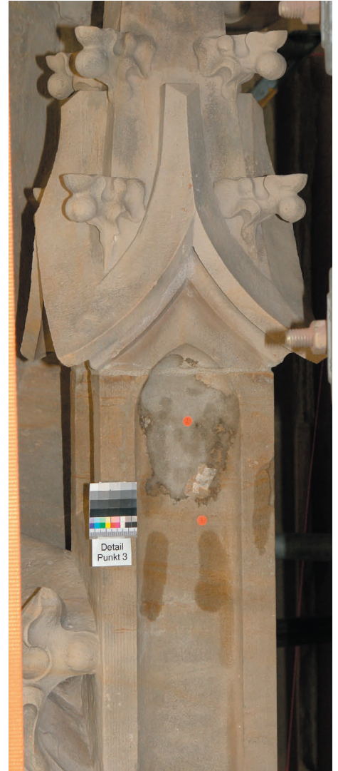
Schlecht haftender und sich kurz nach der Fertigstellung im Sommer 2009 verfärbender Mörtelflick an der Südwest-Fiale. Als Ursache werden eventuelle in der Bauzeit verwendete Oberflächenbehandlungen vermutet.
