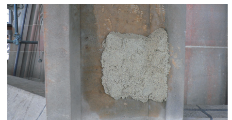
Im Obernkirchener Sandstein noch vorhandene Rückstände von unbekanntem früheren Konservierungsmitteln erschweren die Restaurierung. Oben: hydrophobe Oberfläche, unten: Versuch zur Entsalzung mittels Kompressen.
