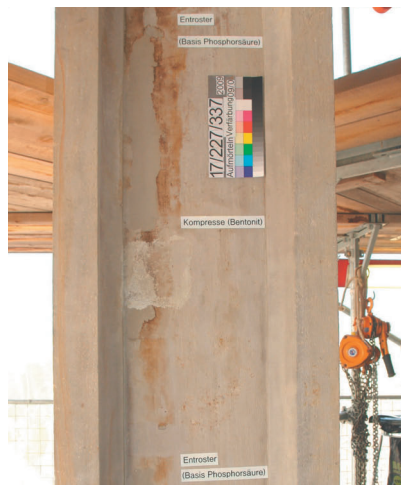
links: Begutachtung von braunen Verfärbungen, welche im Zuge der Restaurierungsarbeiten bei Aufmörtelungen an der Eckfiale Südwest aufgetreten sind. Vermutlich wurden im Stein vorhandene Metalloxide reaktiviert und an die Oberfläche gebracht. Zur oberflächlichen Entfernung der Verfärbungen wurden Versuche mit verschiedenen konventionellen und unkonventionellen Methoden gemacht (rechts).
