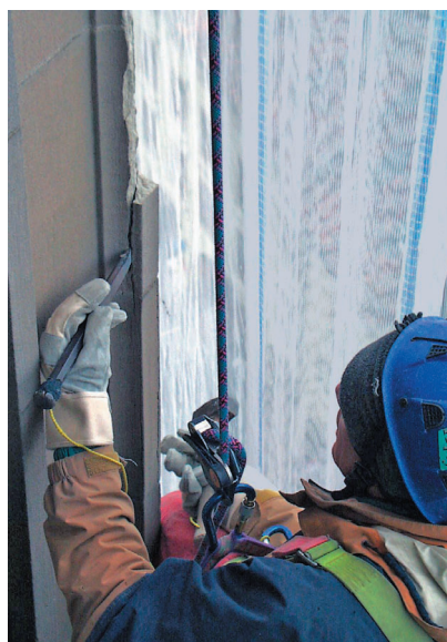
Notabbrüche 2000: Absturzgefährdete Schalen wurden mangels damals bekannter Sanierungstechniken aus Sicherheitsgründen abgeschlagen und zurückgearbeitet.
