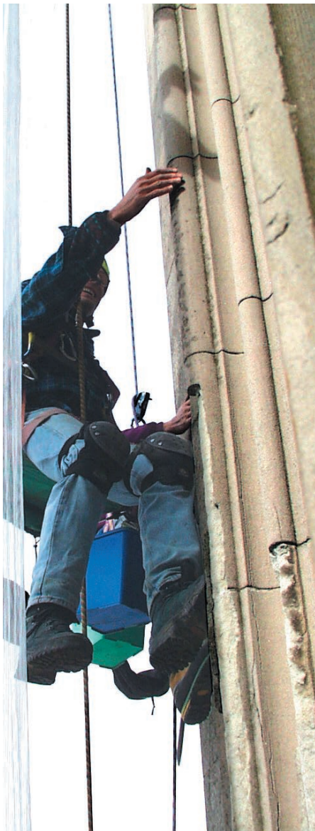
Notabbrüche 2000: Absturzgefährdete Schalen wurden mangels damals bekannter Sanierungstechniken aus Sicherheitsgründen abgeschlagen und zurückgearbeitet.
