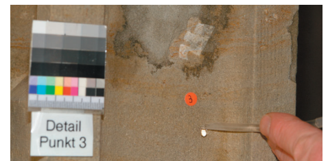
Schlecht haftender und sich kurz nach der Fertigstellung im Sommer 2009 verfärbender Mörtelflick an der Südwest-Fiale. Als Ursache werden eventuelle in der Bauzeit verwendete Oberflächenbehandlungen vermutet.
