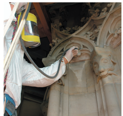
Erste Reinigung der Partien aus Obernkirchener Sandstein mit dem Niederdruck-Sandstrahlgerät.
