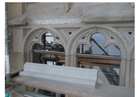
In Bereichen, in denen die Schäden bereits zu weit fortgeschritten sind, wird auf traditionellen Steinersatz zurückgegriffen.
