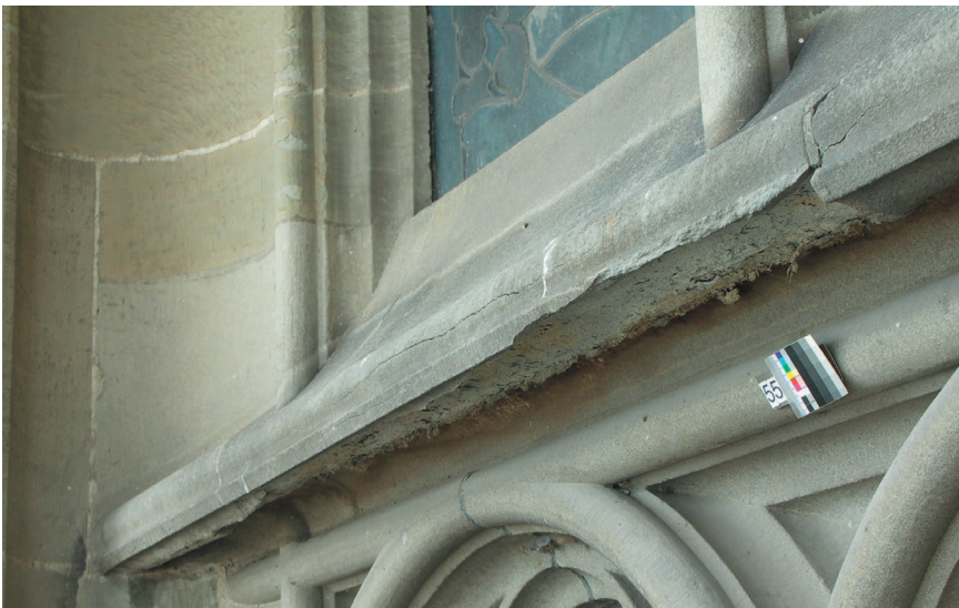
Retten was zu retten ist: Wo immer möglich werden die Masswerkbrücken in den Chorfenstern mittels Rissanierung und Stabilisierung von Schalen konserviert.
