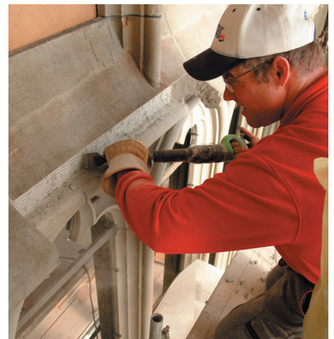
Retten was zu retten ist: Wo immer möglich werden die Masswerkbrücken in den Chorfenstern mittels Rissanierung und Stabilisierung von Schalen konserviert.
