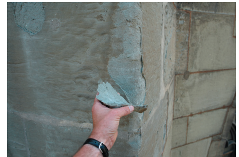
Sicherung von absturzgefährdeten Bauteilen (Schale am Spornpfeiler 25 Nord).
