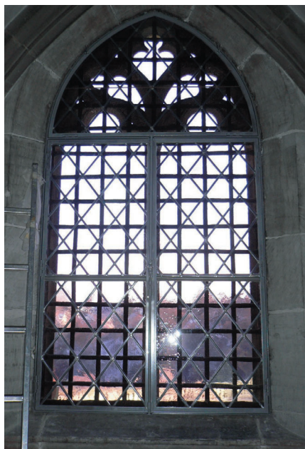
links: Vorzustand mit durch Taubenkot stark verschmutzter Festverglasung, rechts: Mit Öffnungsflügeln umgebautes Fenster nach der Reinigung durch Daniel Stettler und Wiedereinbau durch Carlo von Ballmoos. Die Kirchgemeinde freute sich sehr über die ungewohnt lichtdurchflutete Sakristei.
