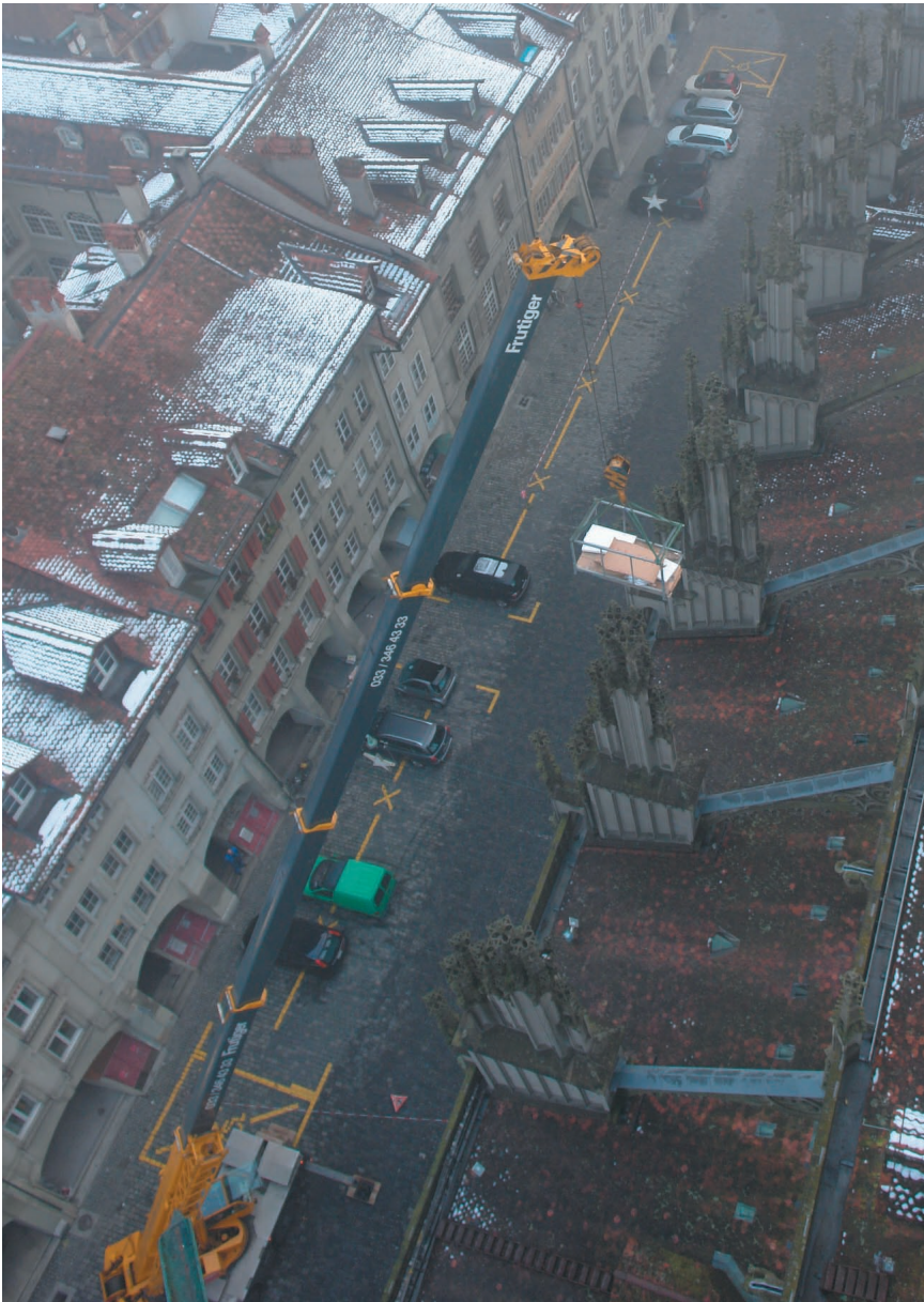
links: Anlieferung der Chromstahlroste mit dem Pneukran über die Hochschiffbrüstungen, vorbei an Strebewerken und Fialen / oben: Montage und Schlusszustand der Galerien mit den begehbaren Rosten.
