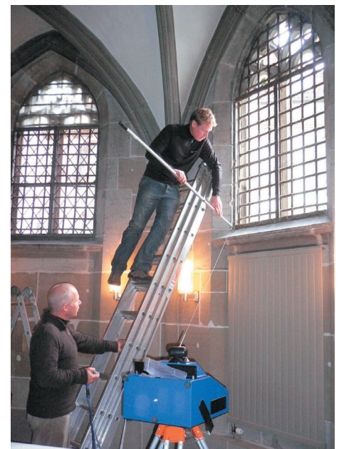
Massaufnahmen an Ort durch den Stahlbauer, zusammen mit einer spezialisierten Firma.
