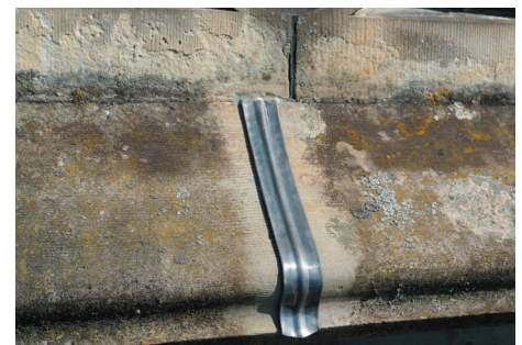
Abdichtung von gerissenen Fugen mit Bleiblechen (diverse Stellen unterhalb der Hoch- und Seitenschiffgalerien).
