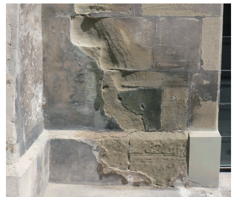
Ansicht Stürlerhaus in Bern, Schäden durch Strassensalz im Sockelbereich.
