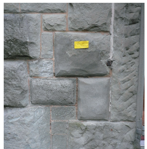
Dreilinden Luzern: Musterflächen im Sockelbereich, ausgeführt durch Peter Völkle, oben: Vorzustand, unten: Mit Aufmörtelung des Bossenmauerwerks.
