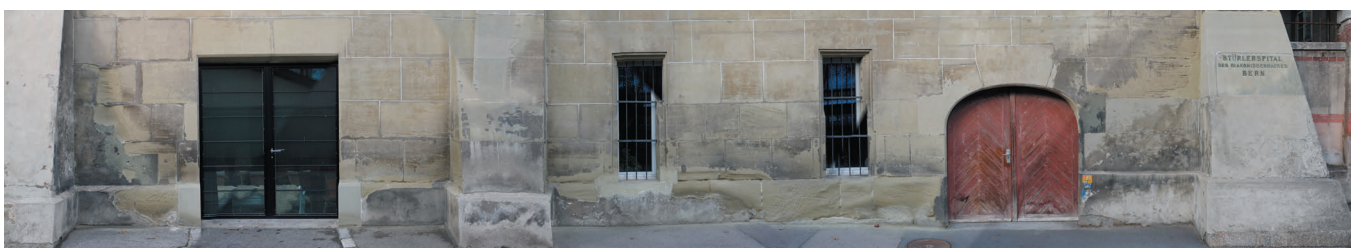
unten: Detail Sockelzone Stürlerhaus, Zustand 2009.
