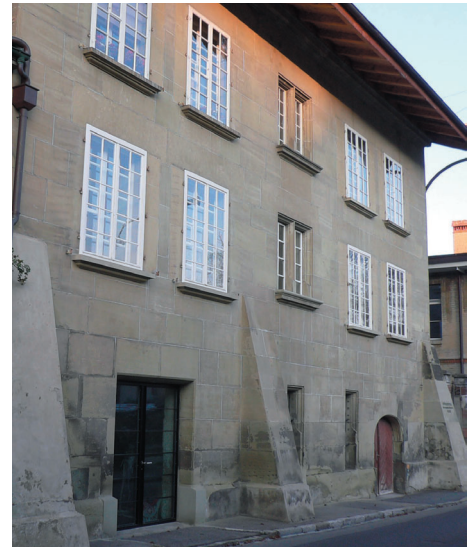
Ansicht Stürlerhaus in Bern, Schäden durch Strassensalz im Sockelbereich.
