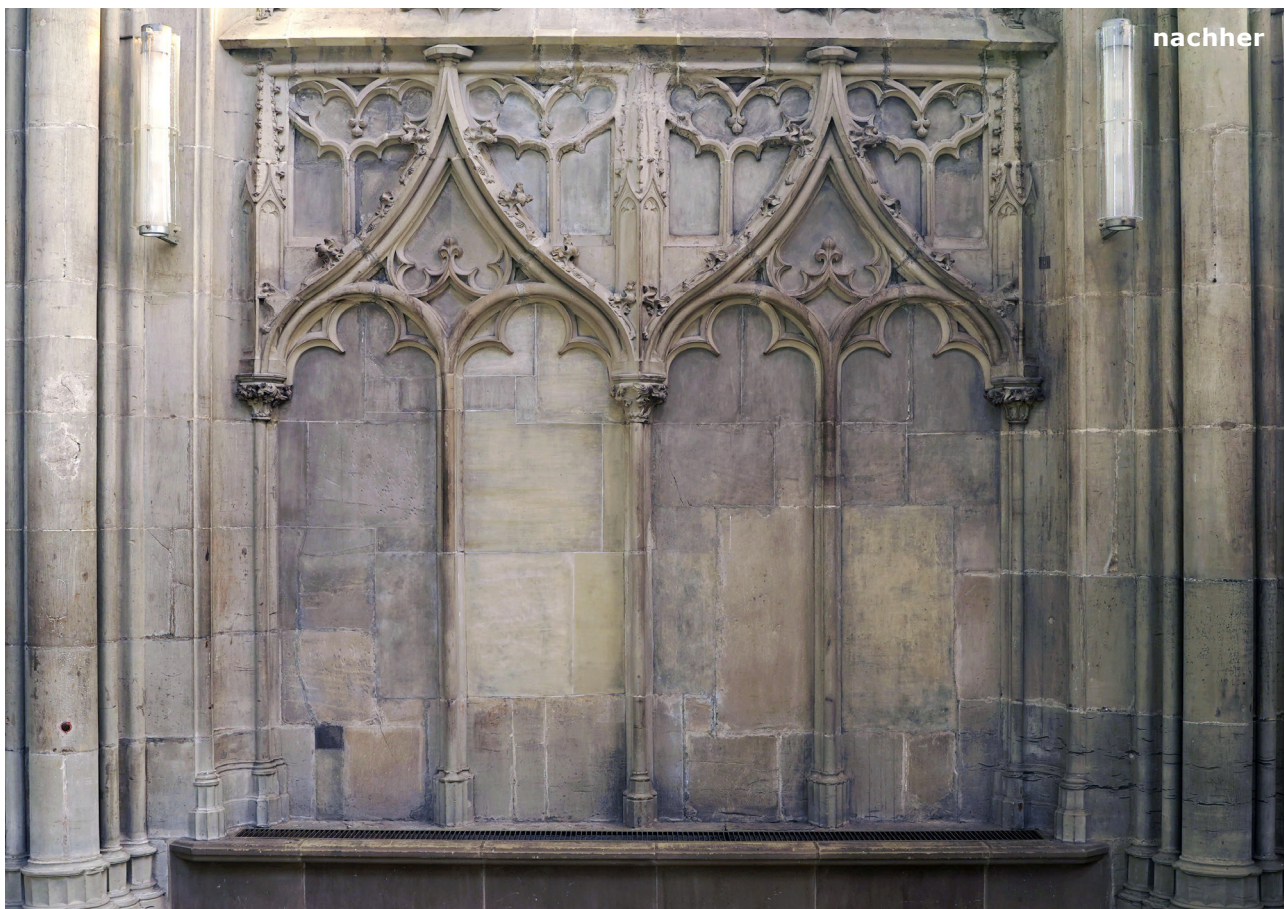
Nordwand im Altarraum: oben Vorzustand, unten Schlusszustand nach der Reinigung und Retuschierung. Foto (o.): Nick Brändli, Zürich.
