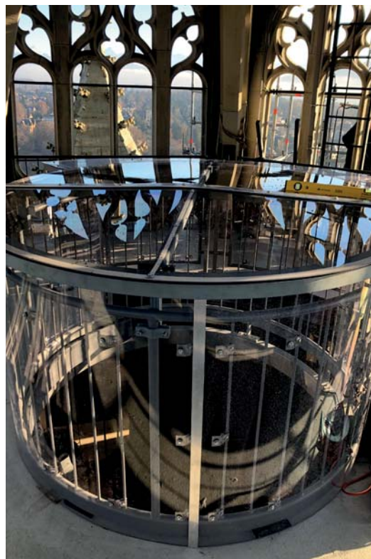
Das filigrane Stahlgeländer des neuen Zuganges in den Turmhelm erhielt einen transparenten Wetterschutz.
