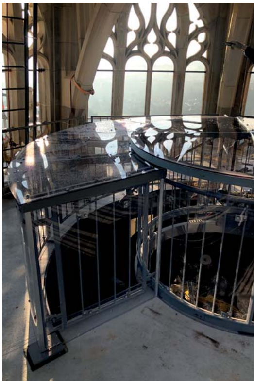
Das filigrane Stahlgeländer des neuen Zuganges in den Turmhelm erhielt einen transparenten Wetterschutz.
