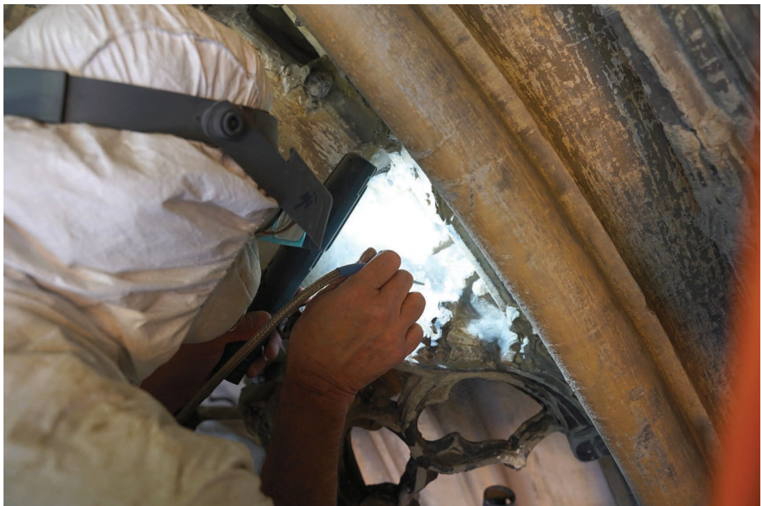
Die Reinigung mit dem Mikrosandstrahlgerät erfordert höchste Konzentration.
