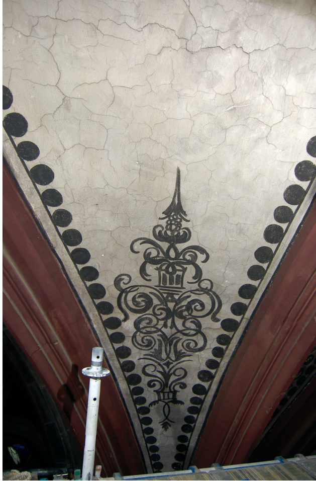
Abb. 25: Gewölbekappe Chor: Zustand vor Anlegen des Reinigungsmusters (Foto: Cornelia Marinowitz)
