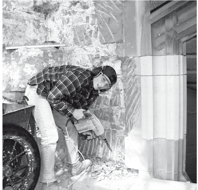
Abb. 6: Oberes Turmviereck West: Abbruch (Foto Juni 2001)
