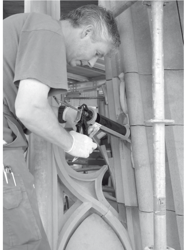
Abb. 17: Einbringen des Verpressmörtels bei den Vierungen am Turmhelm
