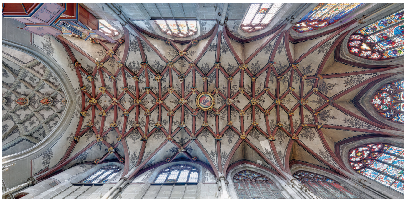
Abb. 23: Blick von unten ins Chorgewölbe (Foto: Nick Brändli, 2012)
