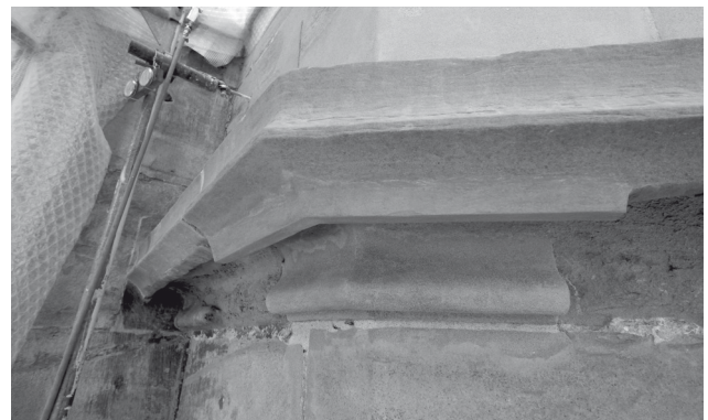
Abb. 22: Aufmörtelung des Profils durch die Münsterbauhütte 2013 (Orientierung am Bestand)
