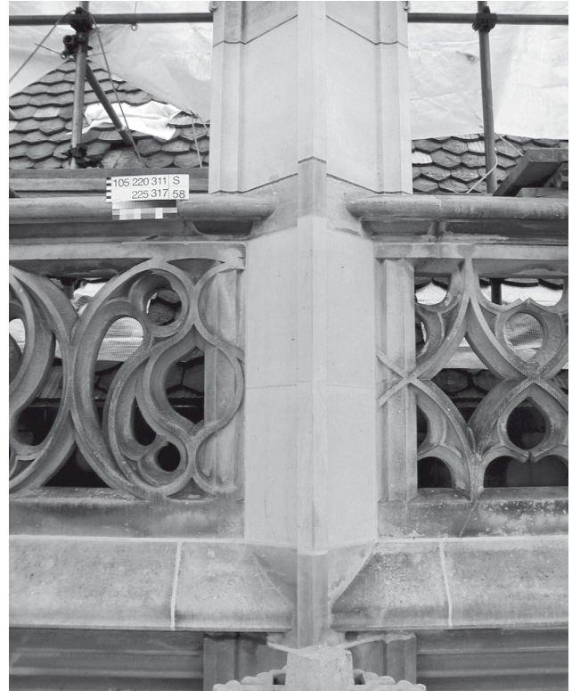
Abb. 17: Ersatz der Werkstücke aus Zuger Sandstein mit Oberkirchener Sandstein. So kann eine bessere Stabilität des Bauteils gewährleistet werden.
