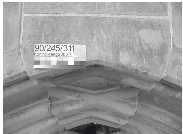
Abb. 15: Detail Schlussstein: Schlusszustand nach der Restaurierung
