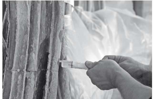
Abb. 10: Sehr wichtig ist die Reinigung des Bohrloches vor der Injektion.
