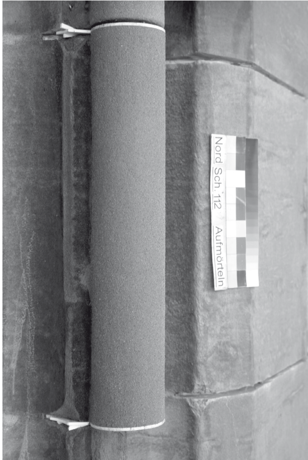
Abb. 15: Fertige Mörteloberfläche, abgetupft mit dem Mikroporenschwamm
