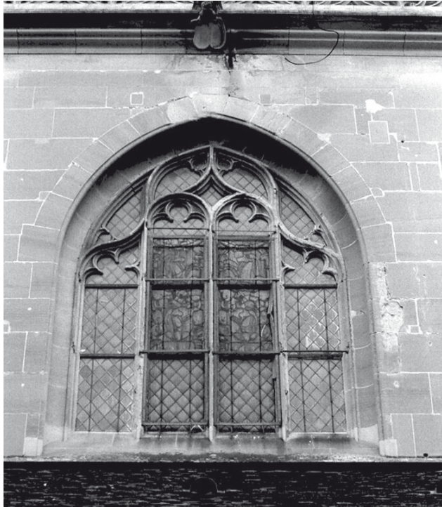
Abb. 18 und 19: Obergadenfenster Nord, Totalersatz durch die Münsterbauhütte 1995
