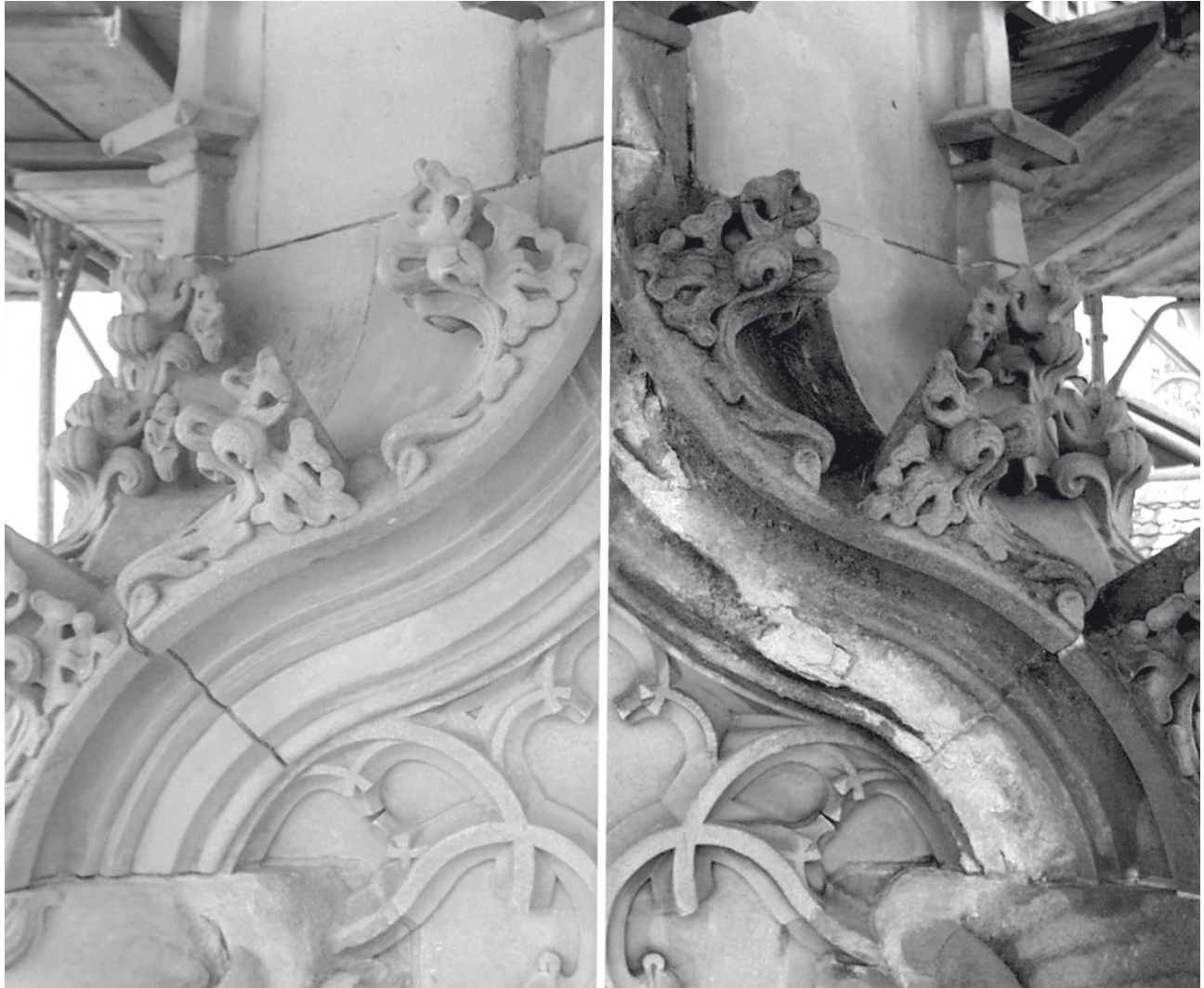
Abb. 10: Baldachin an der Eckfiale Süd 2001. Rechts: Vorzustand, links: kurz vor dem Abschluss der Restaurierung mit Mörtelantragungen als Schutz- und Opferschicht
