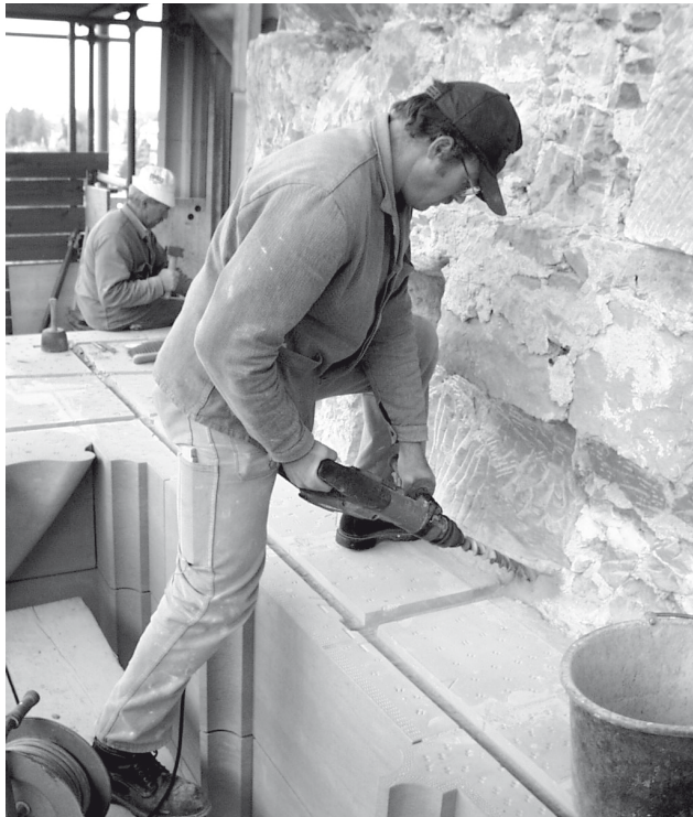
Abb. 7: Oberes Turmviereck West, Erneuerung der gesamten äußeren Mauerschale durch die Münsterbauhütte 2001
