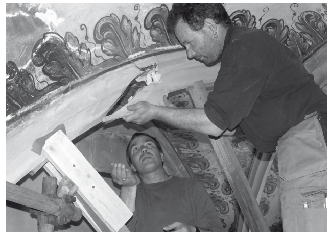
Abb. 3: Vorsichtiges Abnehmen und Sanierung eines fast vollständig gerissenen Rippenstückes (Schütz-Kapelle)
