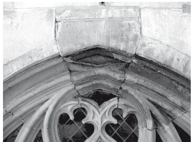
Abb. 14: Detail Schlussstein: Vorzustand
